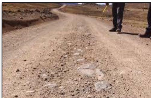
Figura 1. Desgaste en la superficie de afirmado PU-999, Fuente: Elaboración Propia.
