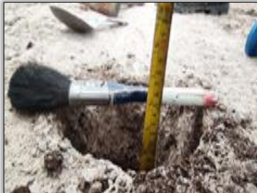
Foto N°04: Medición de la altura de la capa de afirmado.
