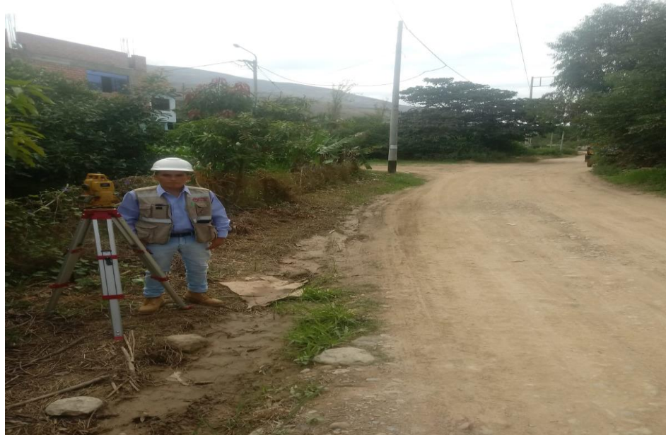
Fotografía N° 01: inicio del tramo de la carretera.
