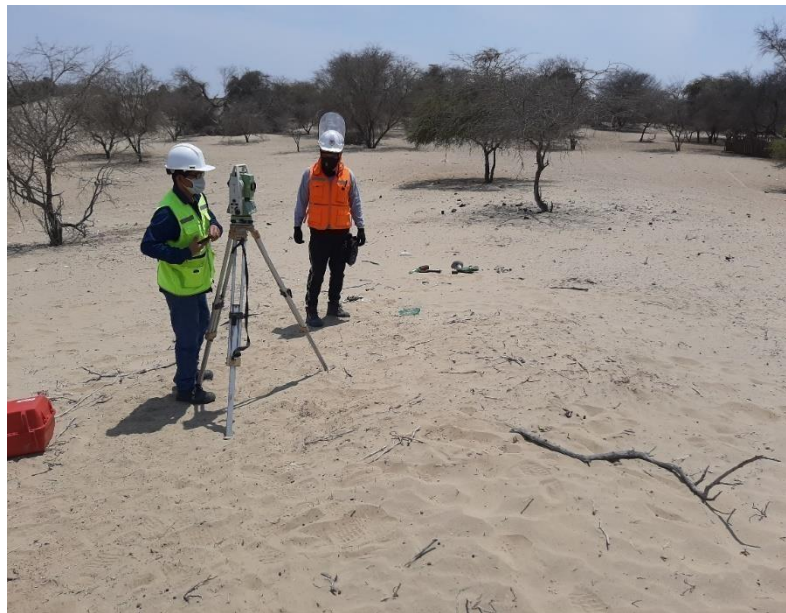
Figura 64. Levantamiento Topográfico Tramo Los Pocitos – Nueva Esperanza (Definición del BM)
