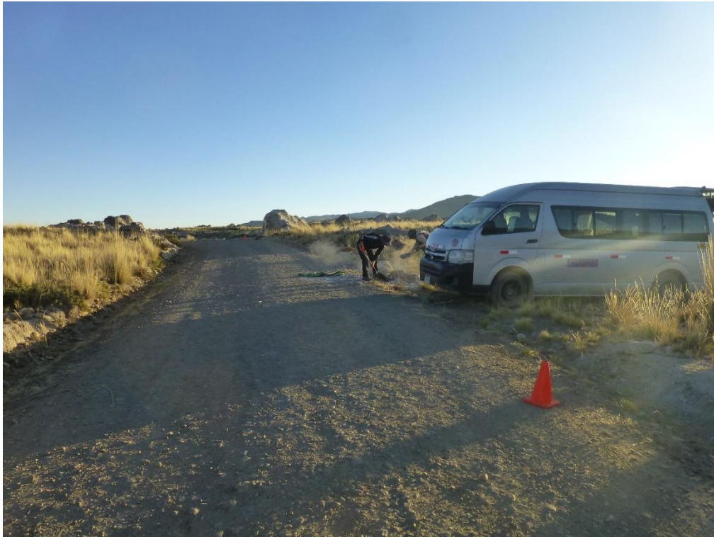
Figura 6 Cerrando las calicatas después del muestreo.
