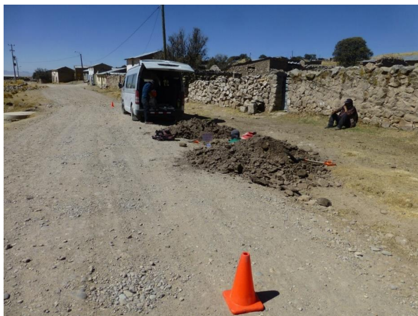
Figura 1 Apertura de Calicatas.
