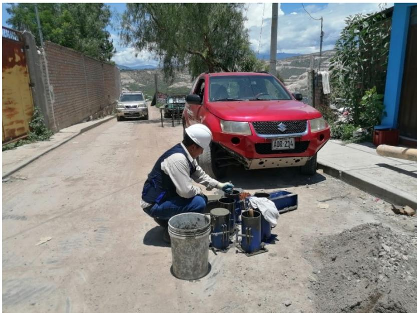
**Figura 31:** Preparación de probetas y vigas de concreto
