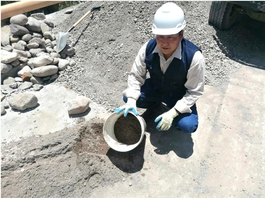
**Figura 64:** Selección de agregado fino para concreto
