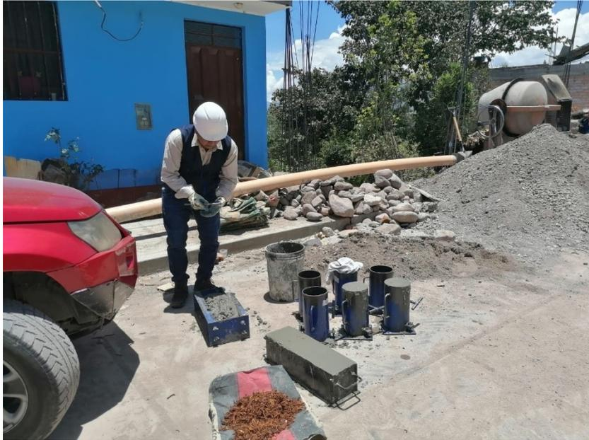
**Figura 30:** Adición de fibras de mazorca de cacao al concreto
