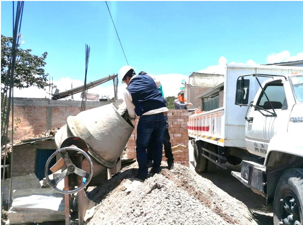
**Figura 66:** Preparación de mezclas de concreto
