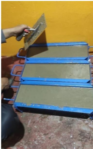
Fotografía 12. Vaciado y acabado de viguetas de concreto
