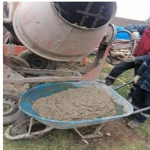
**Figura 5** Preparación del concreto
