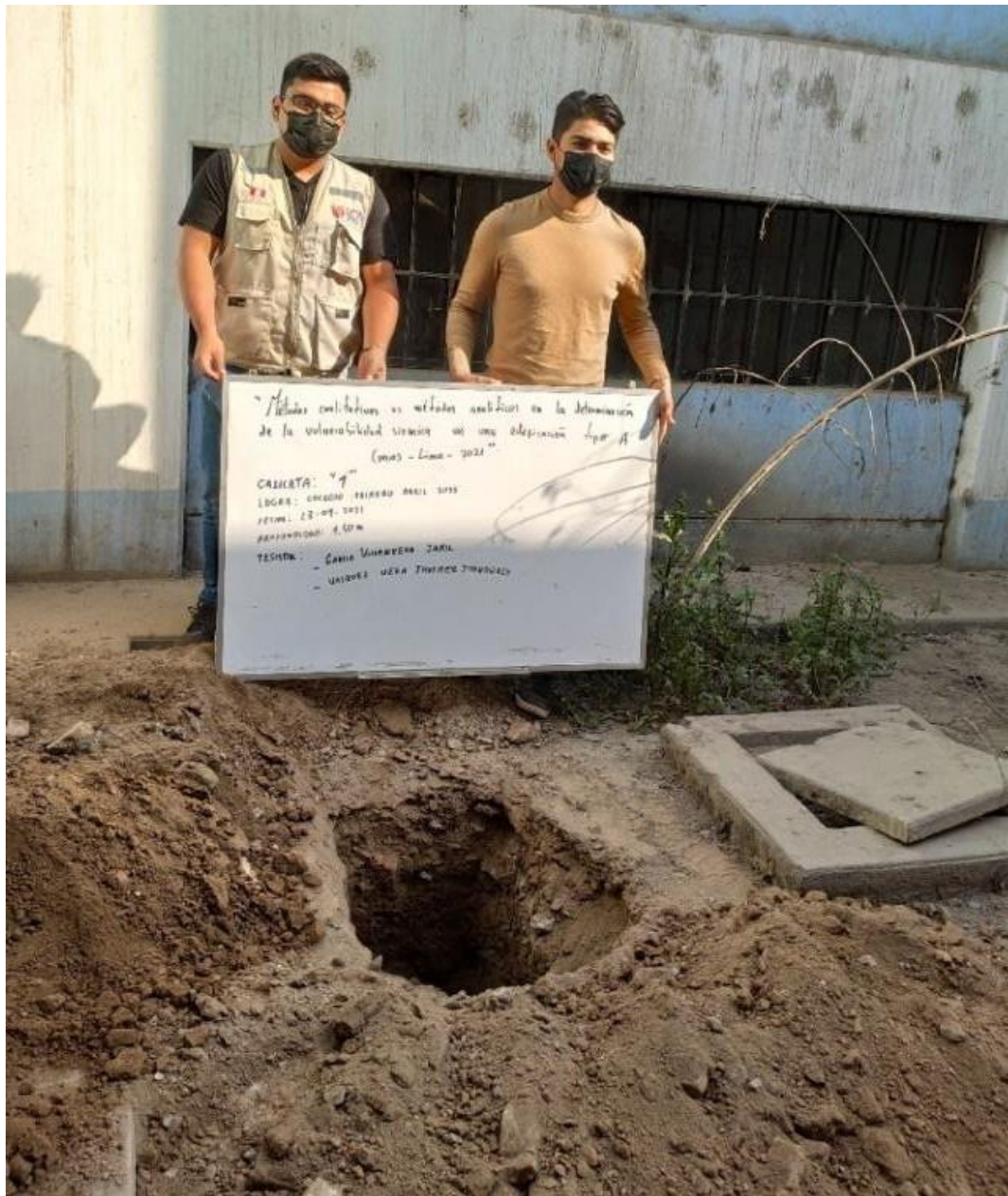
Figura: Excavación de calicata C1.
