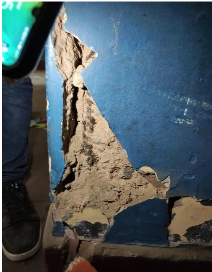
Figura 16: Columna interior expuesta en Modulo B. Fuente. Elaboración propia.
