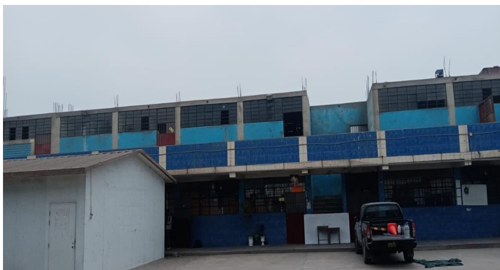
Figura 11: Imagen de fachada de Pabellón B del colegio Primero de Abril 2055.
