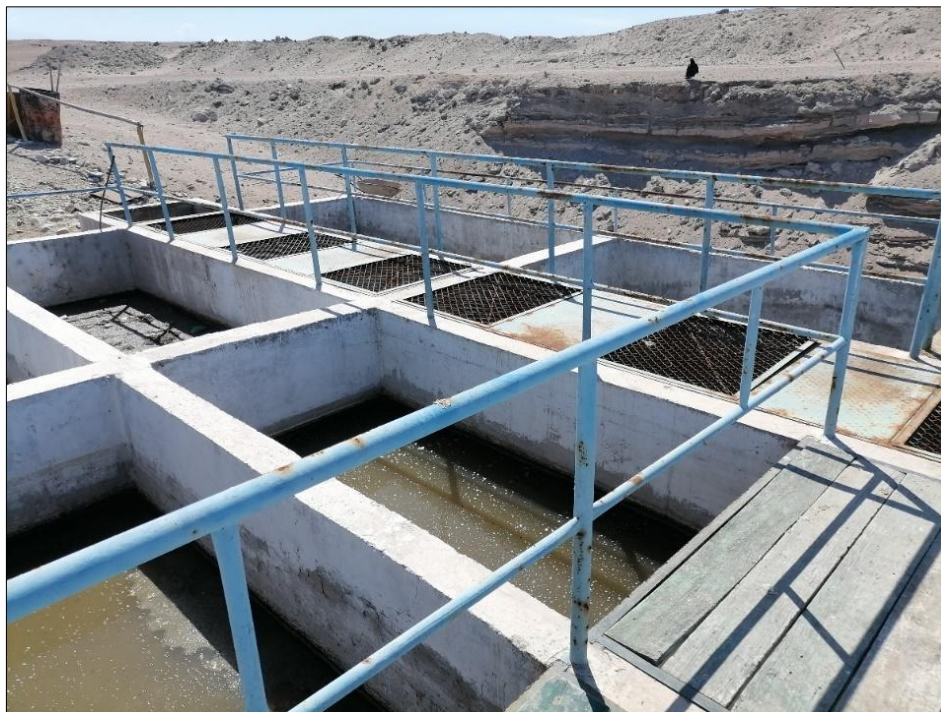
Figura 10 Cámara de espumas y de sedimentación (Tanque Imhoff) Fuente: Propia
