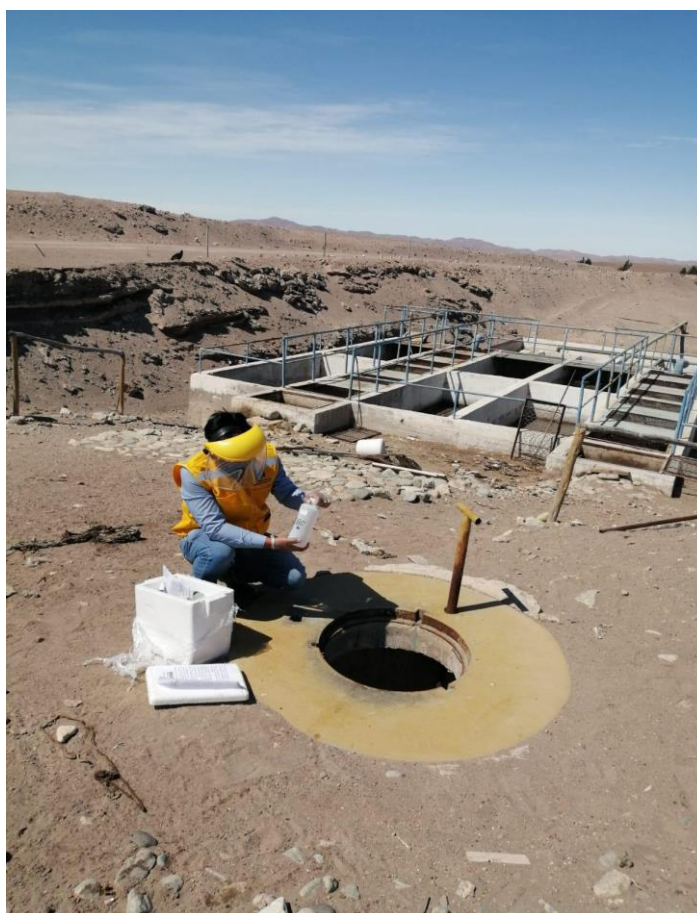
Figura 19 Toma de Muestra DBO 5 Ingreso a PTAR
