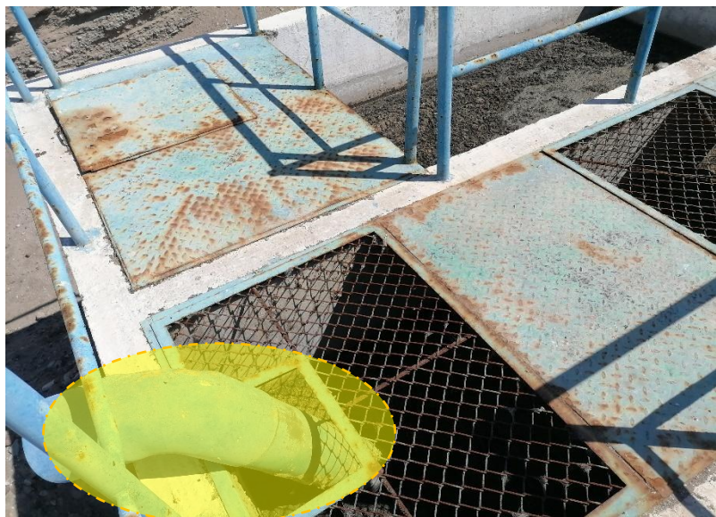
Figura 16 Tanque Imhoff Existente – conducto de limpieza Fuente: Propia
