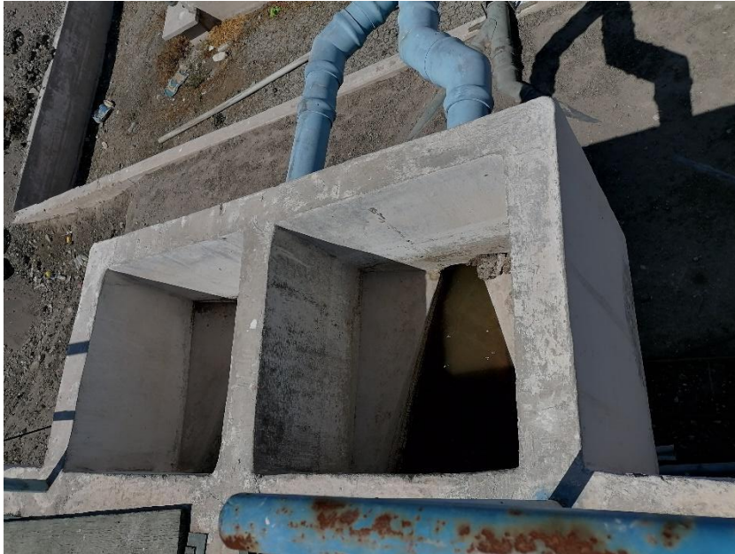
Figura 17 Tanque Imhoff existente – registro de toma Fuente: Propia
