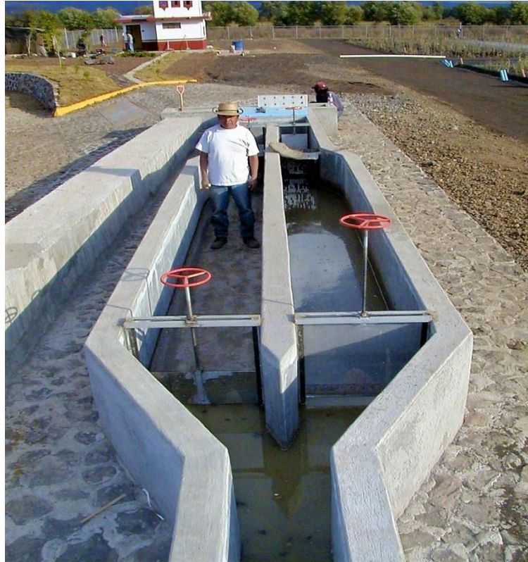
Figura 2 Desarenador de Santa Fe de la Laguna. Fuente: Rivas s.f.
