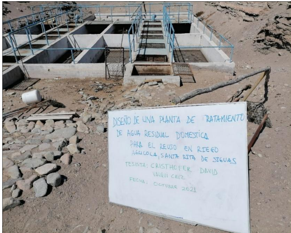
Figura 9 Tanque Imhoff (tratamiento primario) Fuente: Propia
