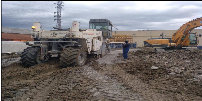
Figura 8. Máquina para la estabilización de suelos.
