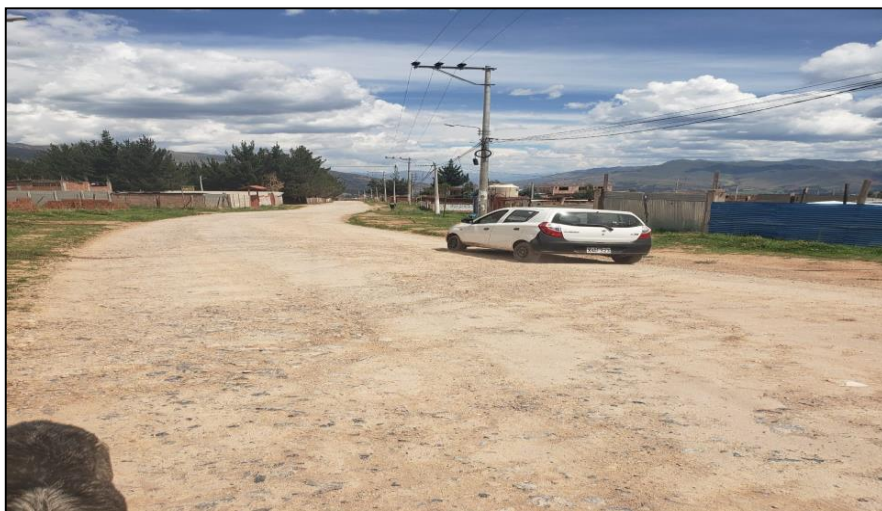
Figura 1. Carretera sin pavimentar.
