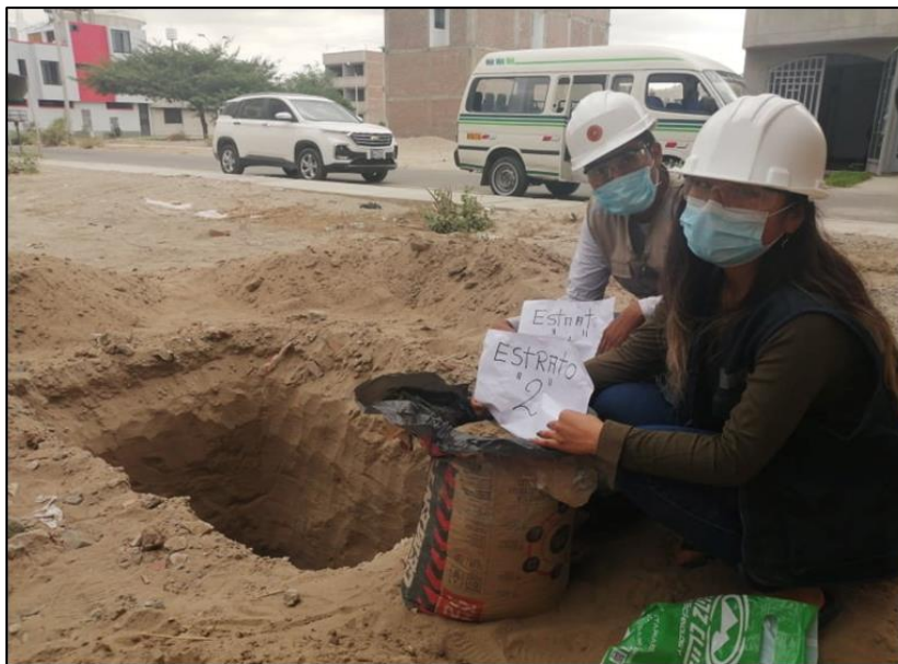
Figura 8. Extracción de muestras de suelos, para su análisis en laboratorio.
