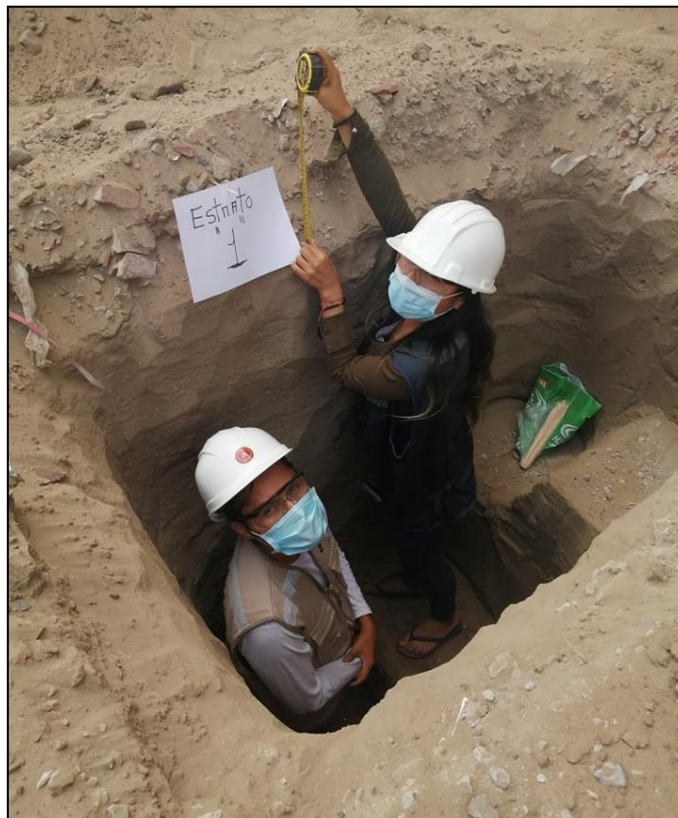
Fotografía 4. Medición de los estratos de la calicata.
