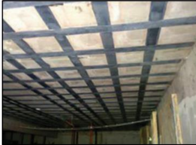
Figura 2. Reforzamiento de la edificación con fibra de carbono. Fuente: Borja y Torres (2015)
