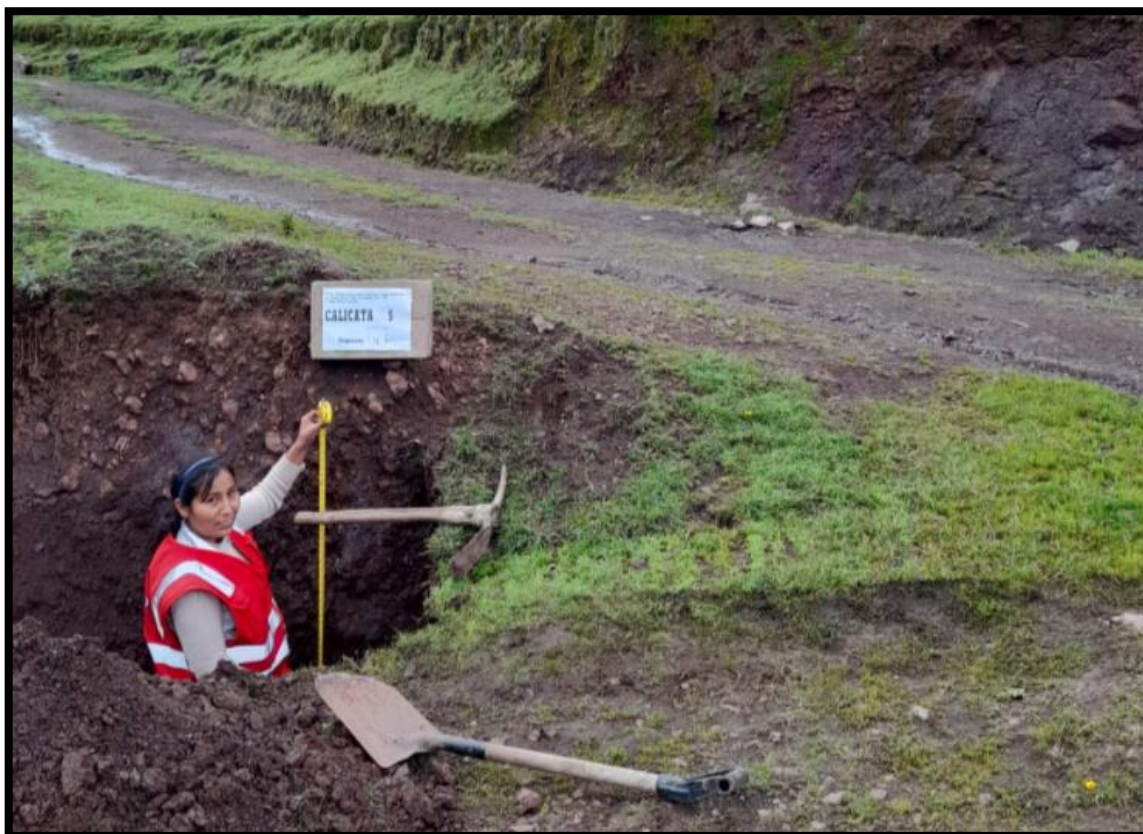
Excavación de la calicata 05, en la progresiva
