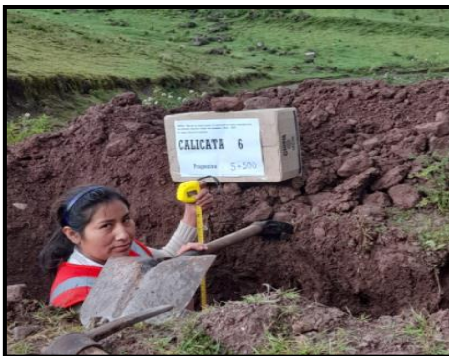
Excavación de la calicata 06, en la progresiva
