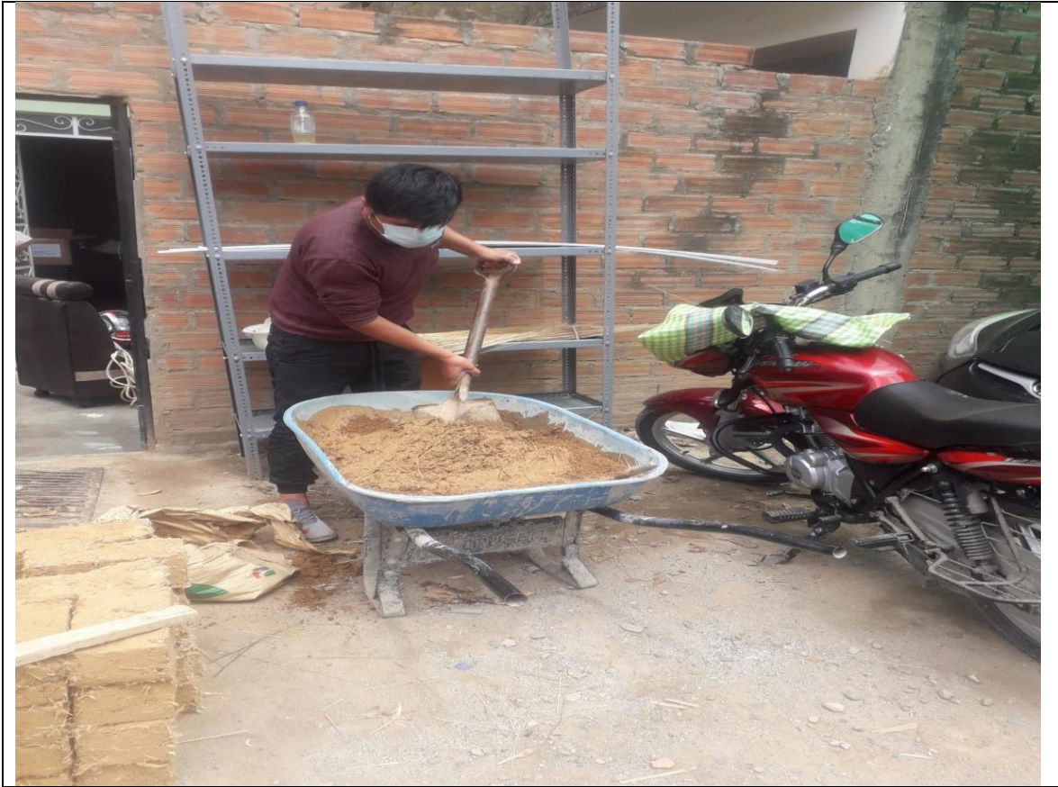
Fotografía 22. Preparación del mortero
