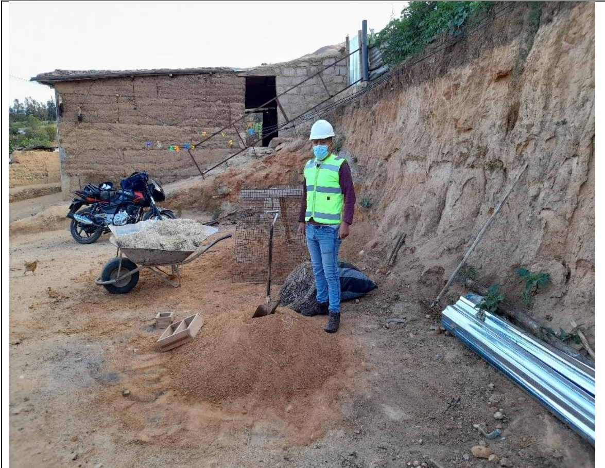
Fotografía 13. Volumen de tierra para la primera muestra con 4 % de plumas de pollo
