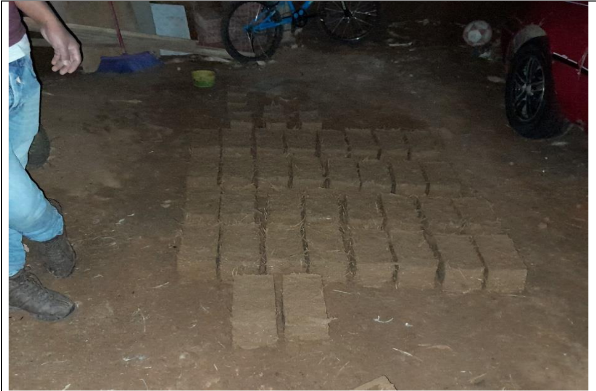
Fotografía 18. Avance de la elaboración de los adobes muestra 1
