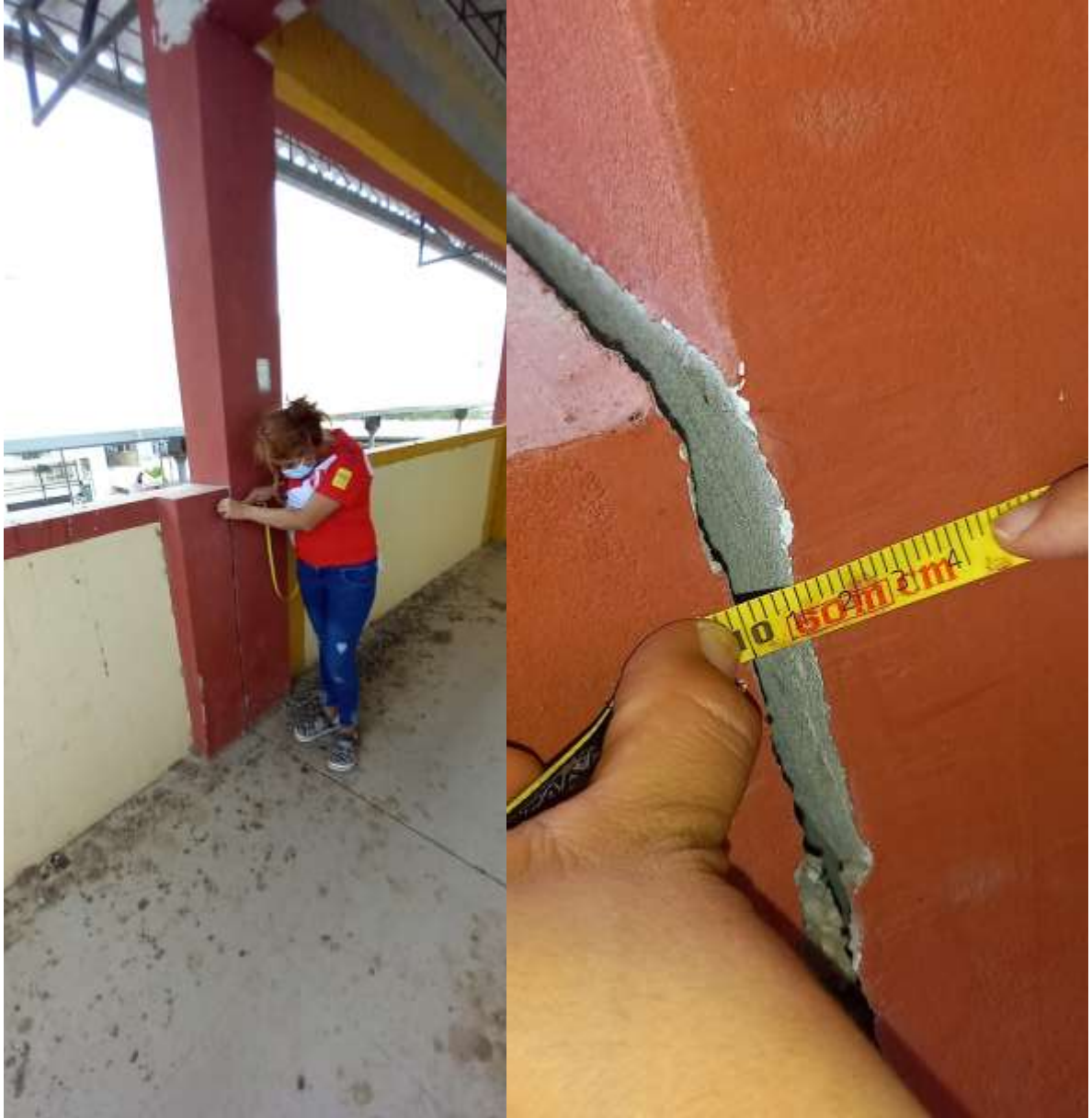
Fotografía 19. Muestra 5. Observación y medición de junta de separación entre edificios siendo menor de 1 pulgada.
