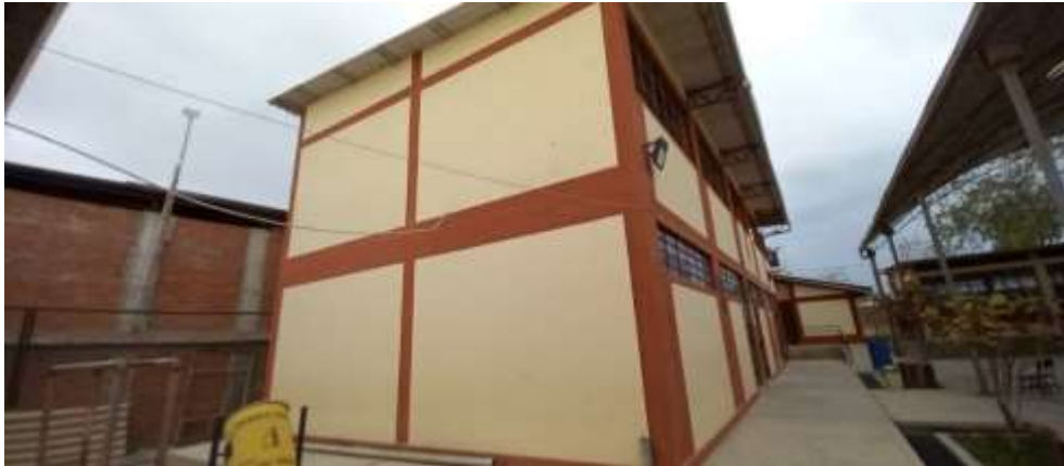
Figura 16. Pabellón de 02 niveles con cubierta inestable de material ligero y en buen estado
