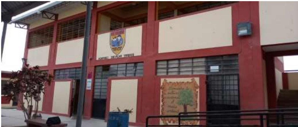
Figura 18. Pabellón de 02 niveles con óptimas conexiones de balcones y parapetos a la estructura.
