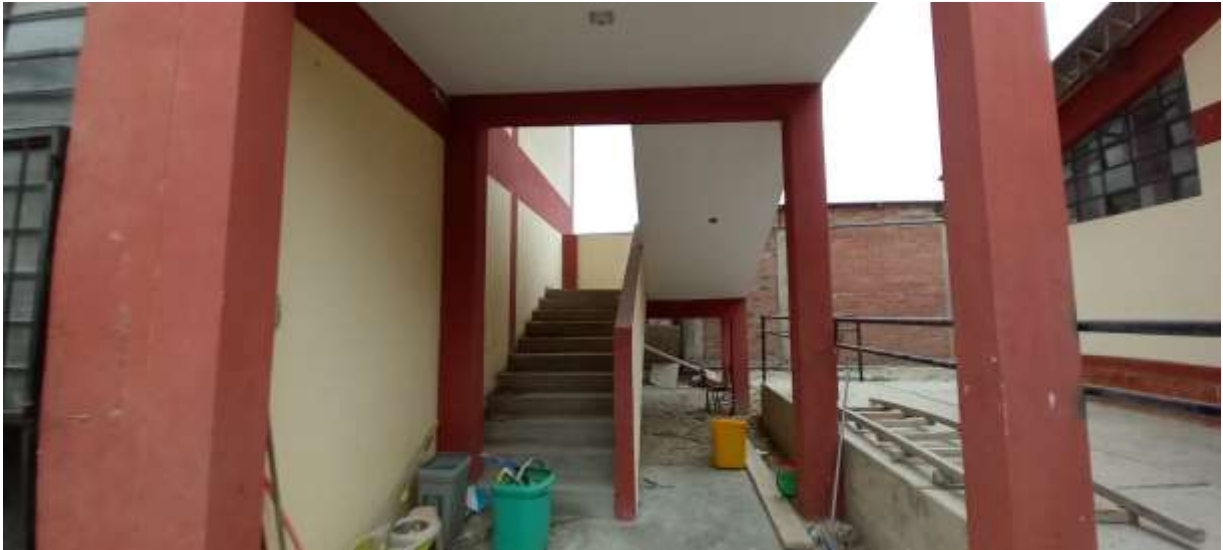
Fotografía 11. Estructura para escalera única en la I.E.
