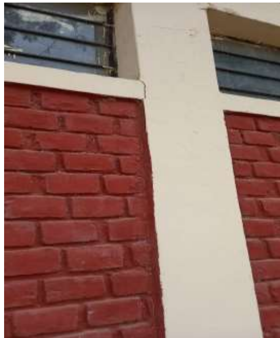
Figura 8. Fotografía. Muestra 13. Pabellón de 01 nivel de la I.E
