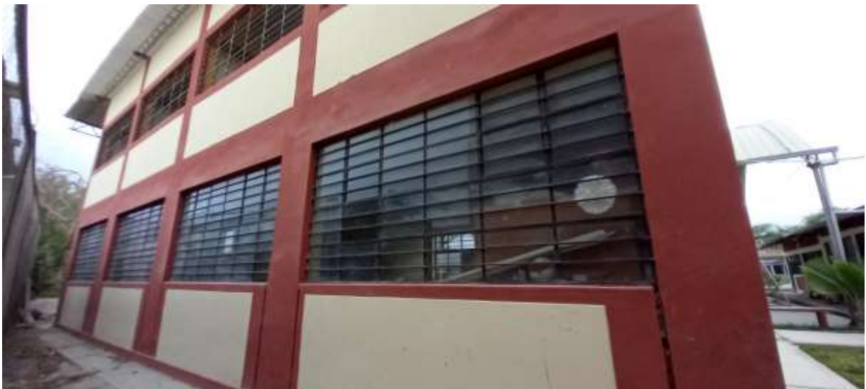
Fotografía 6. Posterior de Pabellón de 02 niveles.
