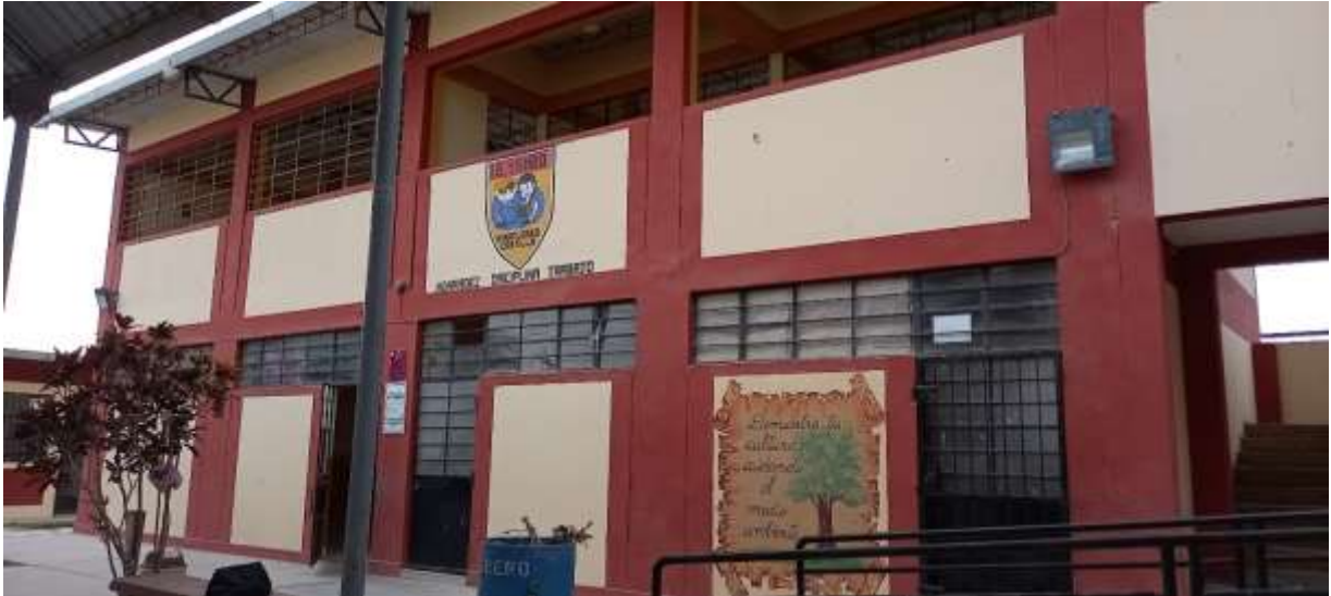
Fotografía 5. Pabellón único de 02 niveles en la I.E. Primer piso se ubica dirección y segundo piso aún deshabilitado por instalaciones pendientes.
