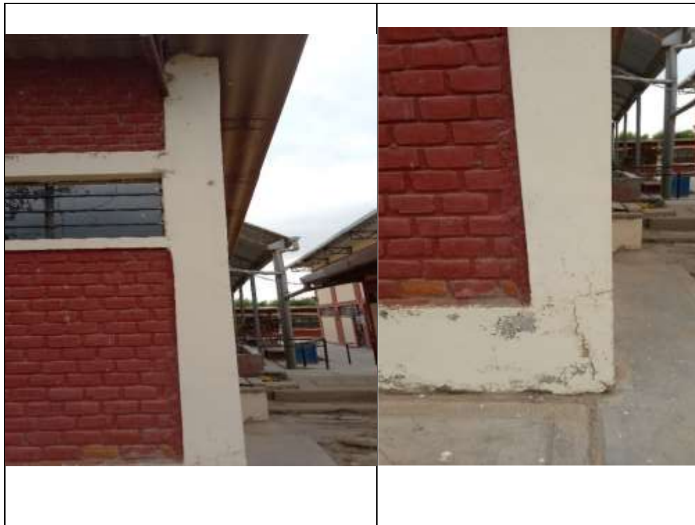
Figura 7. Fotografía. Muestra 11. Pabellón de 01 nivel de la I.E.
