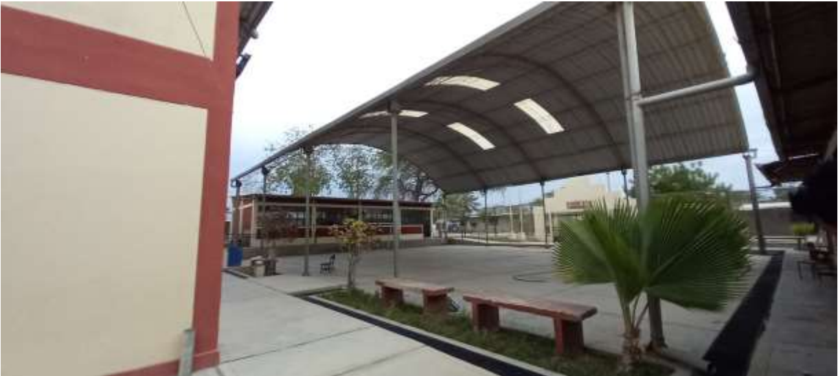
Fotografía 7. Patio de la I.E. Comprende techado de estructura metálico parabólico, plataforma deportiva y áreas verdes.
