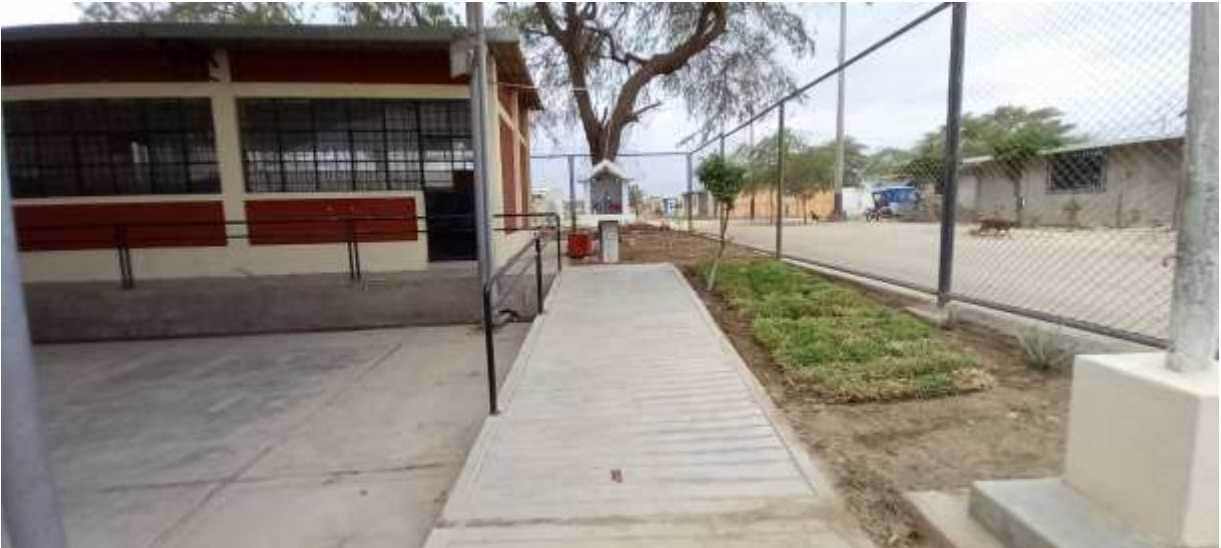
Fotografía 9. Rampas de acceso para aulas de clases y en varios puntos de la I.E.
