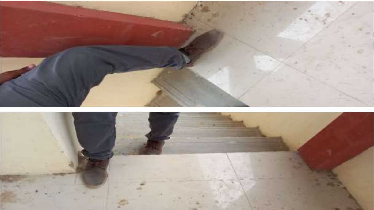
Fotografía 20. Muestra 6. Observación de pasos y descanso de escalera.
