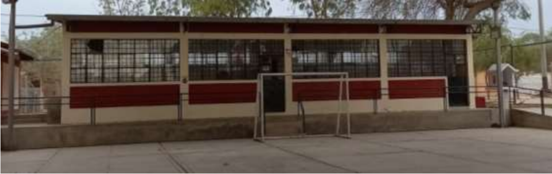
Figura 15. Vista Frontal del pabellón de 01 Nivel (Elevación de la Edificación)
