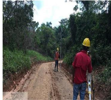
Figura 19. Levantamiento topográfico del tramo 02
