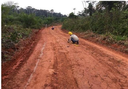
**TOMA Nº 15:** Se muestra la medición ancho de la vía y la longitud de los puntos críticos de la carretera del distrito de Nueva requena en los tramos 02.
