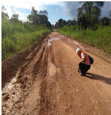
*Figura 14. Medición de la ancho medio de la carretera tramo 01*
