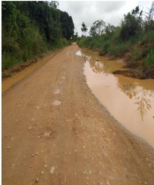
**TOMA N° 01:** Tramo 01 de punto crítico muestra la sección lateral inadecuado de severidad alto en la progresiva 3+000.
