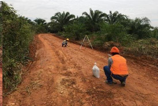
**TOMA Nº 16:** Se muestra la medición de ancho de vía y la longitud de los puntos críticos de la carretera del distrito de Nueva requena en los tramos 03.
