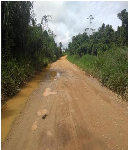
**TOMA N° 02:** Tramo 02 de punto crítico muestra la sección lateral inadecuado de severidad media en la progresiva 7+000.
