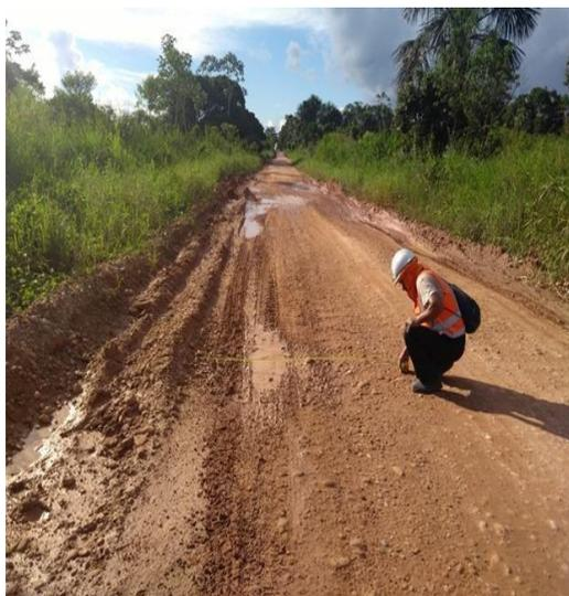
**TOMA N° 03:** Tramo 03 de punto crítico muestra la sección lateral inadecuado de severidad alto en la progresiva 10+000.
