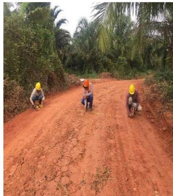
*Figura 15. Medición de la ancho medio de la carretera tramo 02*
