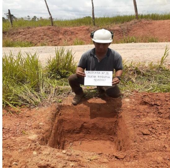
**TOMA Nº 06:** Se muestra la excavación de la calicata Nº 03 en la progresiva 10+000.
