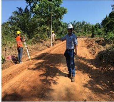
Figura 18. Levantamiento topográfico del tramo 01
