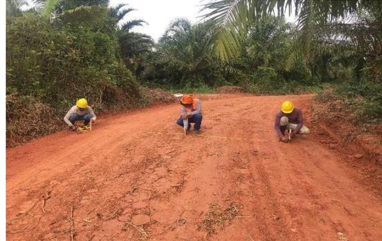
**TOMA Nº 14:** Se muestra la medición del ancho de la vía y longitud de la carretera del distrito de Nueva requena en los tramos 01.
