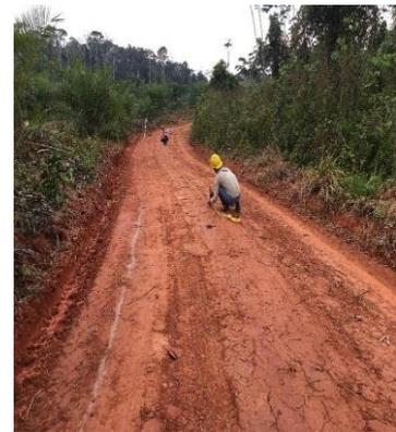
*Figura 16. Medición de la ancho medio de la carretera tramo 03*
