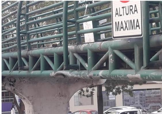
Figura 18: Daño estructural en la estructura del puente
