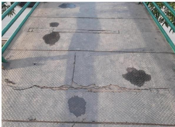
Figura 19: Planchas metálicas en muy mal estado
