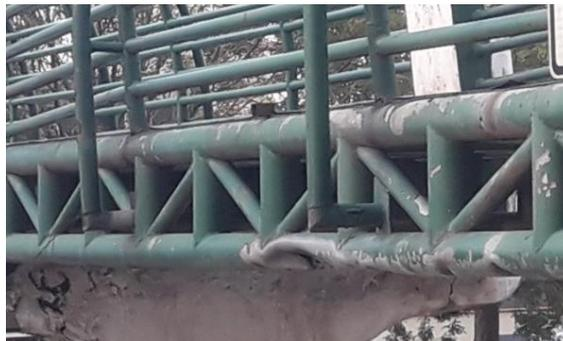
Figura 36: Abolladura en la viga principal de la estructura metálica
