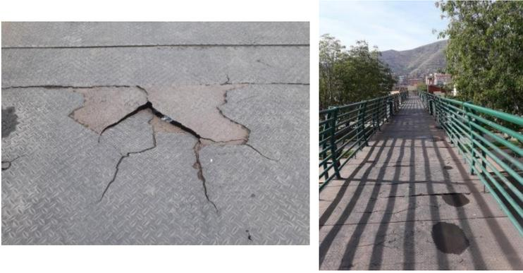
Figura 35: Estructuras metálicas en mal estado
