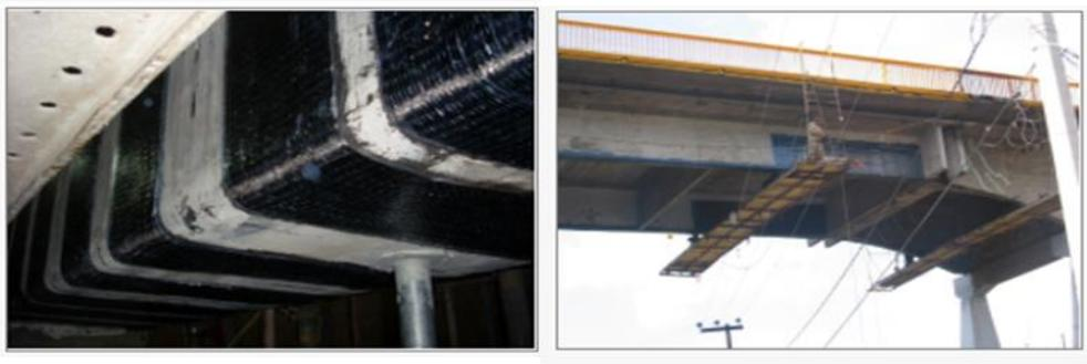
Figura 34: Reforzamiento por método de fibra de carbono
