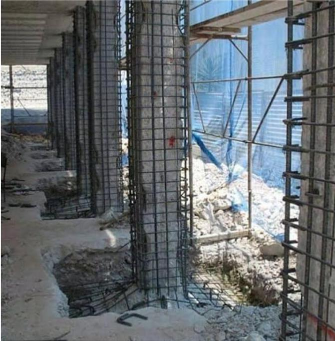
Figura 32: Reforzamiento por encamisado para columnas
