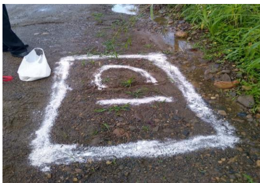
Fotografía 1. Replanteo para la excavacion de calicatas
