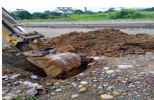
Fotografía 2. Excavacion de calicatas
