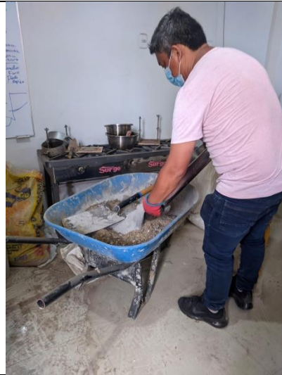
se aprecia la preparacion del mortero
