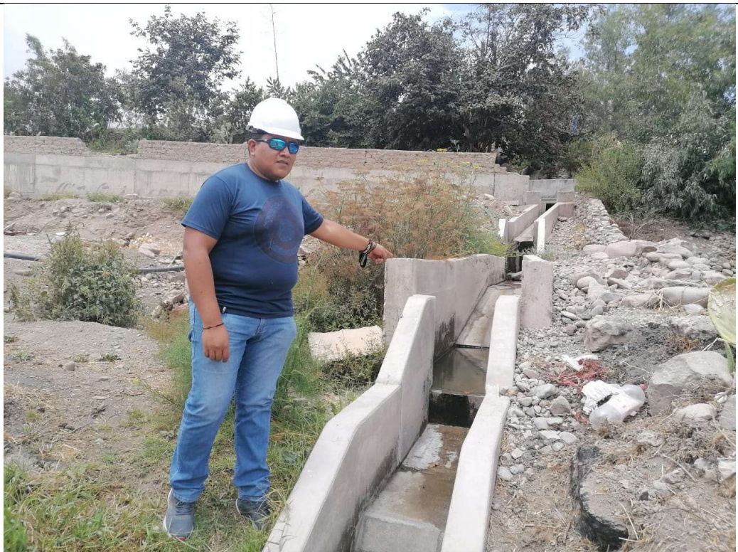
Visita a campo: Ubicación de ingreso de caudal en el canal de concreto.
