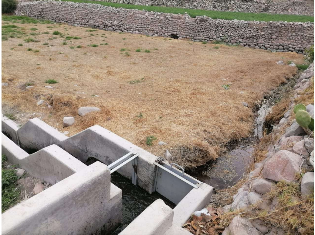
Visita a campo: Evaluación de caudal en canal de tierra, caudal adicional al canal de concreto.
