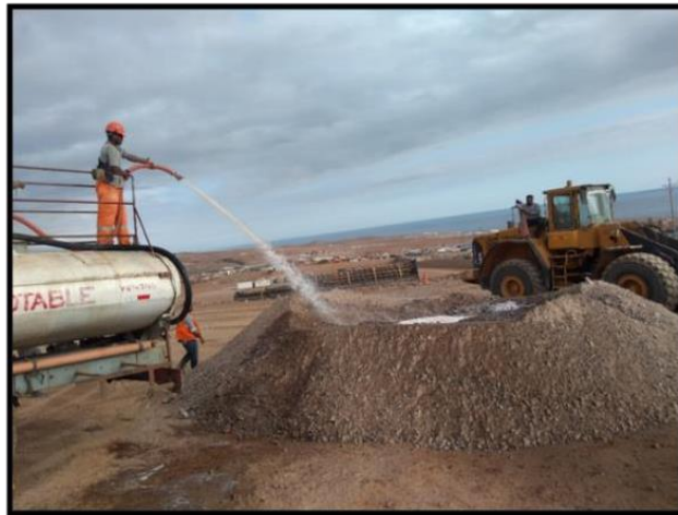
Figura 2. Mezcla del Stabl Soil con el suelo.
