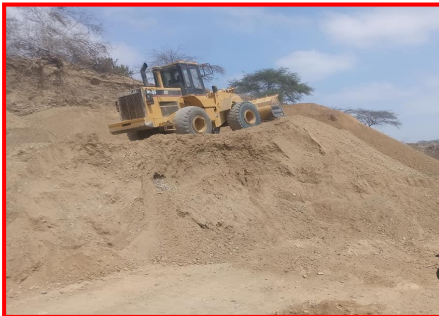
Figura 37. Vista de trabajo con cargador frontal, en cantera Tres Tomas.
