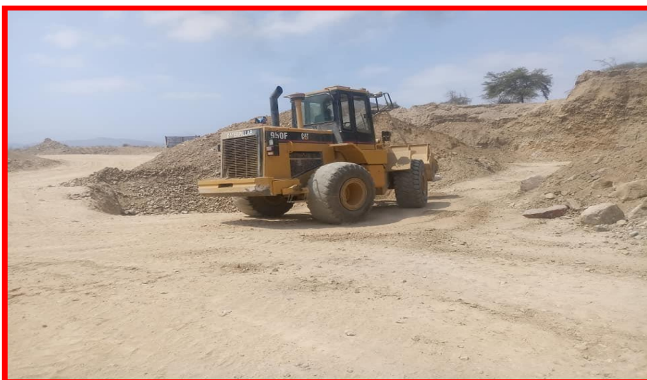
Figura 38. Vista de Acopio de afirmado en cantera Tres Tomas.
