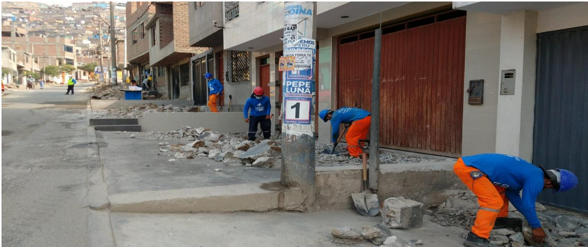
Figura 6. Construcción de veredas
