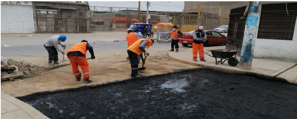
Figura 5. Construcción de pistas
