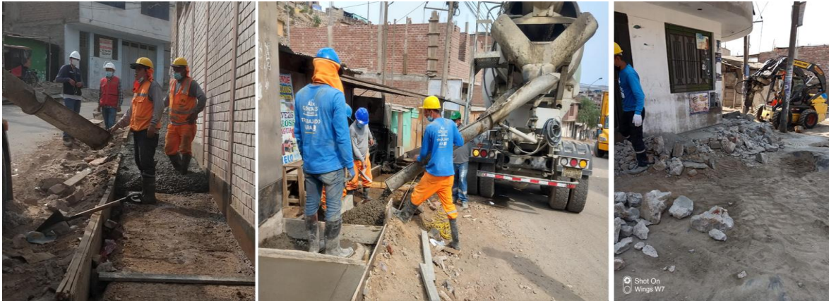
Figura 4. Construcción de veredas
