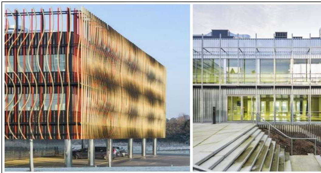
Figura 8: Estructura de perfiles metálicos y carpintería Fuente: Luc Boegly - Archdaily
