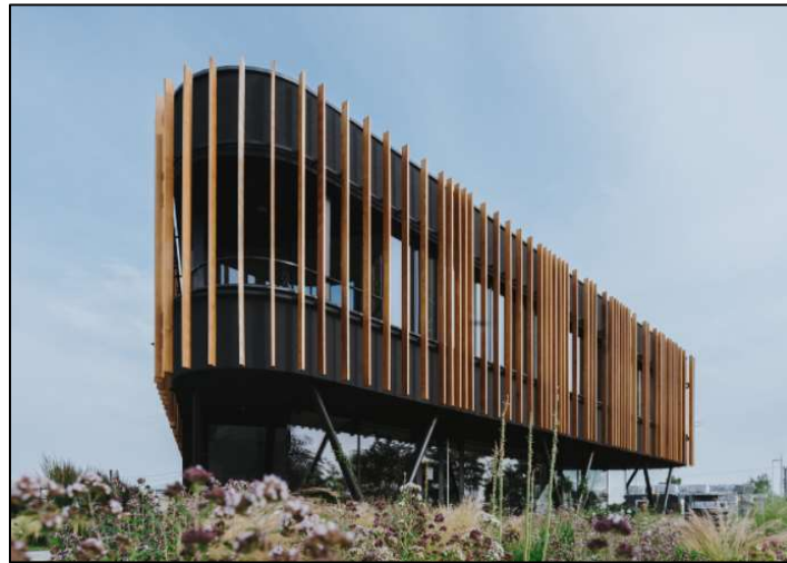
Figura 23: Fachada de Edificio de Oficina ABW - Eslovaquia Fuente: Welinna – Archdaily
