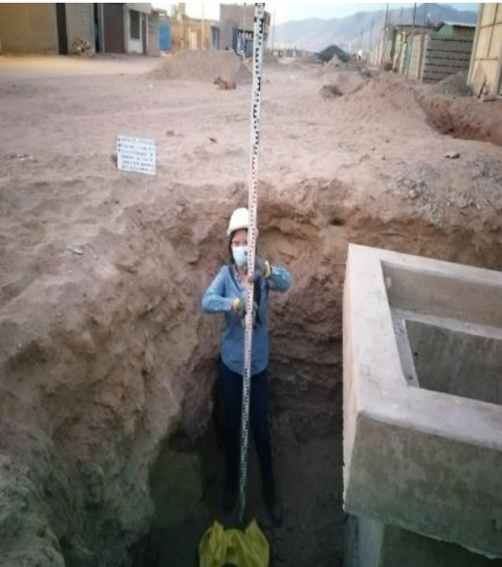
IMAGEN N°3: Se observa los estratos, altura y muestra del suelo de la excavación de la calicata 03
