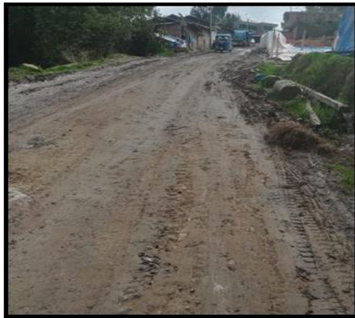
Figura 10 Carretera Andahuaylas Chaccamarca Km 3+000
