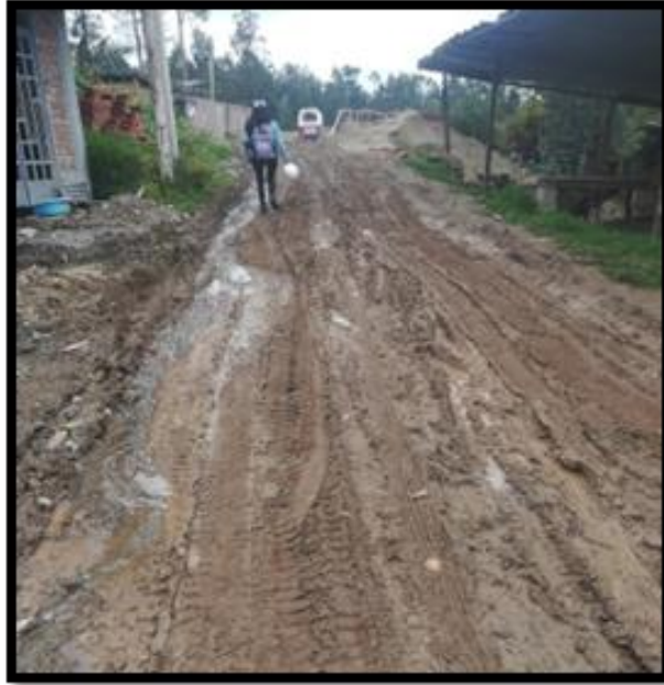
Figura 21 Vista de tipo de suelo KM 4+000
