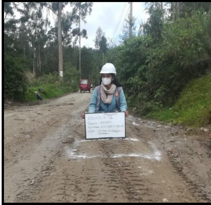
Figura 12 Delimitación de Calicata N° 02 Km 2+500
