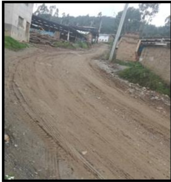
Figura 22 Vista de tipo de suelo KM 2+000
