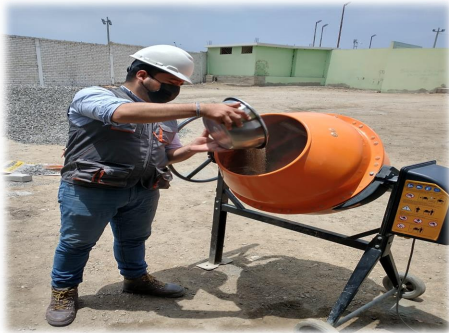
Elaboración de concreto con agregado de reemplazo.
