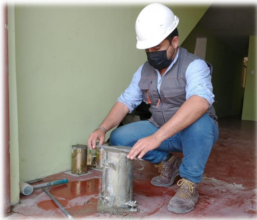
Enrazado de concreto con agregados reemplazos.
