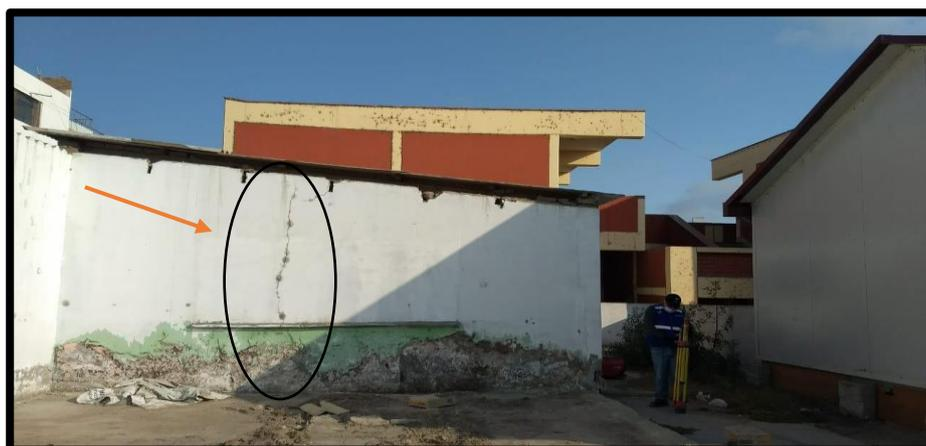
**Figura 2.** Muro de albañilería confinada se encuentra en muy mal estado.
