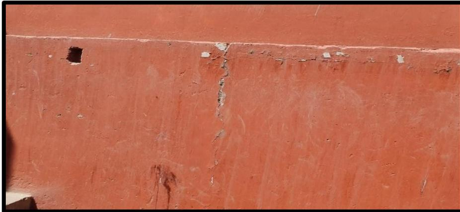
**Figura 4.** Sobrecimiento de concreto armando de la I.E. presentando fisuras de espesores considerables, poniendo en riesgo a colapso.
