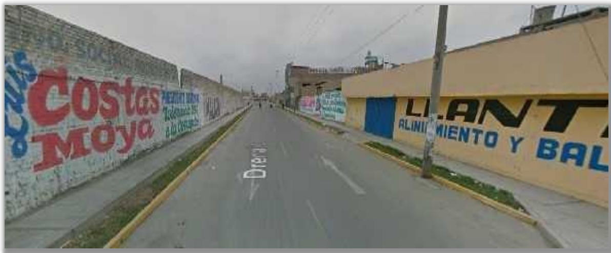
Figura 14: Estado actual de la sección vial Jr. Drenaje
