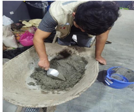
Mezcla de concreto.
