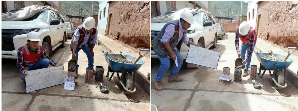
Fotografía 19 y Fotografía 20 Vaciado del concreto en las briqueteras de 15*30 cm, segunda capa.
