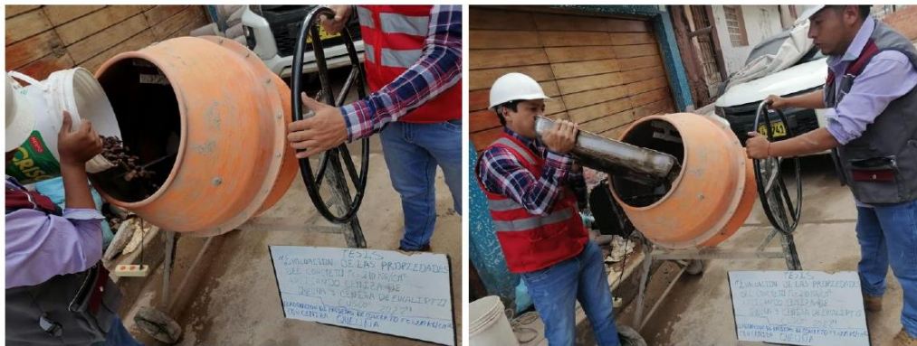
Fotografía 15 y Fotografía 16 Mezclado de los componentes en el trompo de mezcla de concreto.
