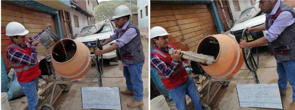
Fotografía 13 y Fotografía 14 Preparación de concreto.
