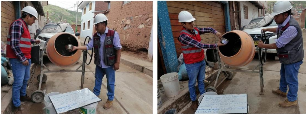
Fotografía 11 y Fotografía 12 Mezclado de los compontes en el trompo de mezcla de concreto.
