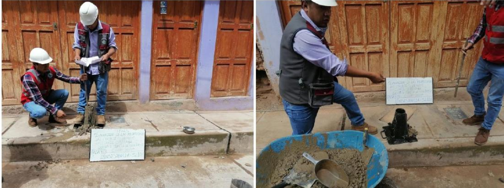
Fotografía 1 y Fotografía 2 Determinación del SLUMP, concreto patrón.
