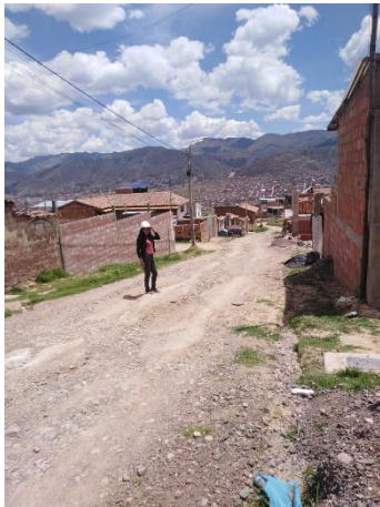
FIGURA 1. Reconocimiento de la subrasante de la calle Luceros de francia.
