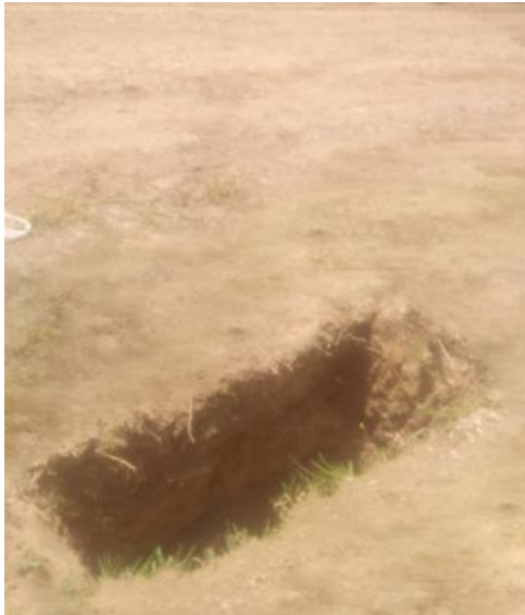
FIGURA 9. Calicatas ya excavadas en la calle luceros de francia.
