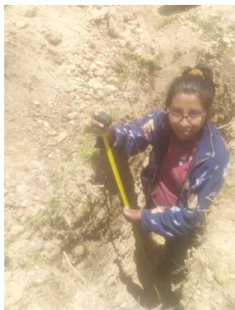
Figura 13. Profundidad de la excavación de la calicata
