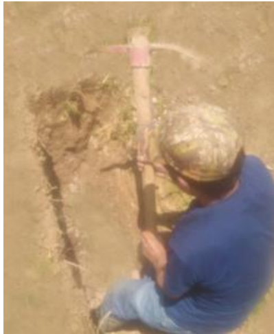
FIGURA 7. Excavacion de las calicatas en la calle luceros de francia
