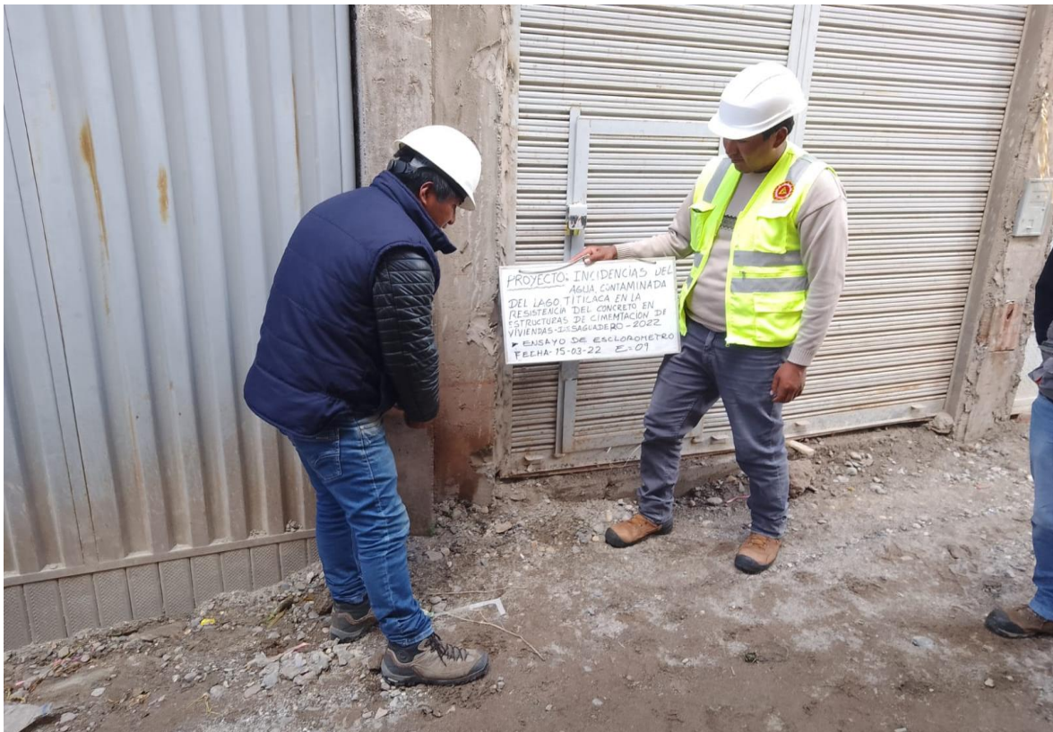
Fotografía 10 Ensayo de Esclerómetro en columnas en viviendas de desaguadero.
