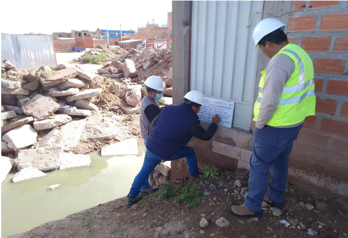
Fotografía 08 Ensayo de Esclerómetro en contacto con agua en viviendas de desagadero.
