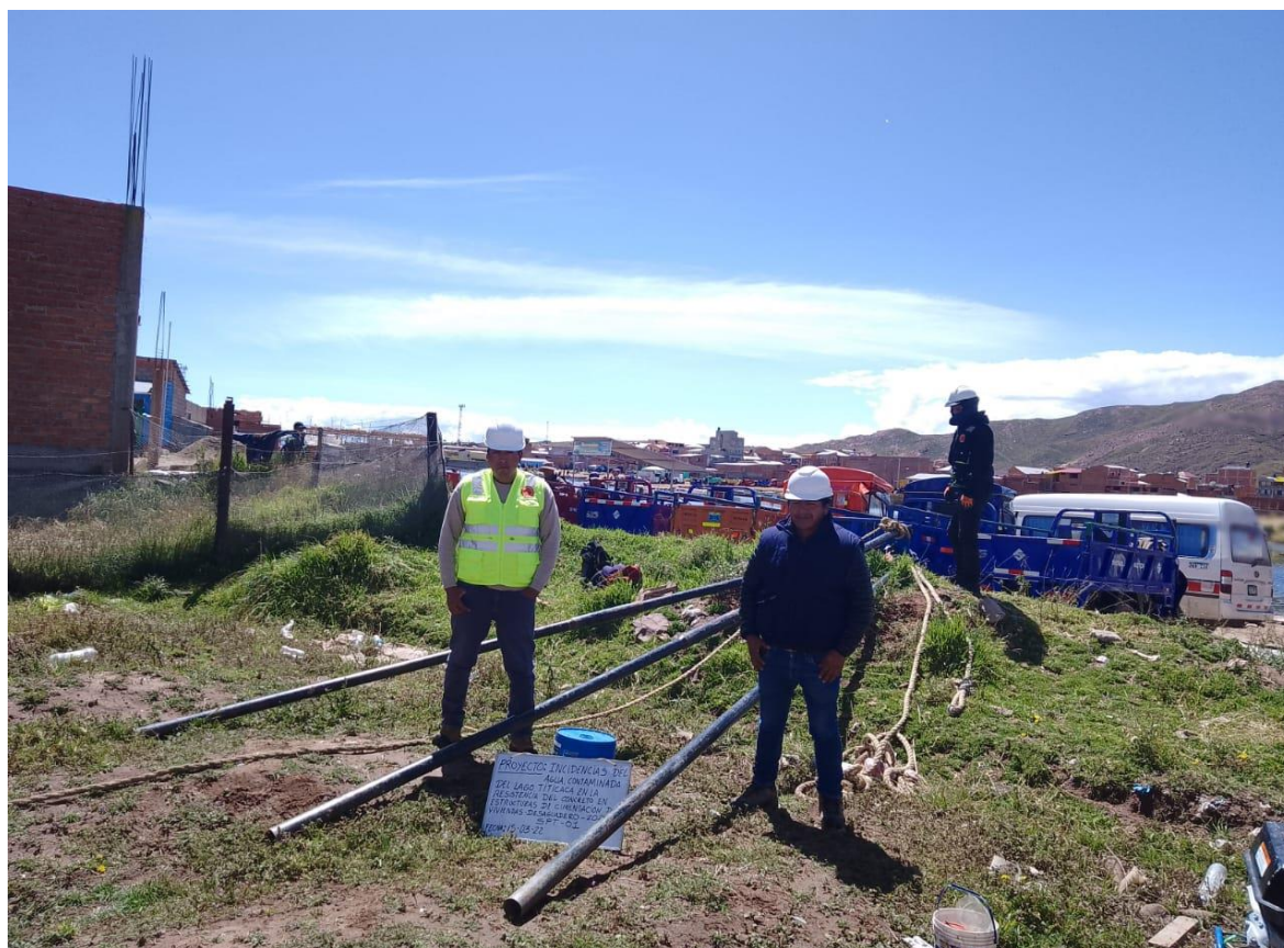
Fotografía 02 instalación del equipo Ensayo de Penetración Estándar (SPT).
