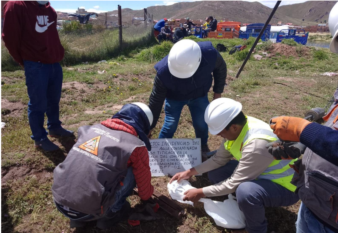
Fotografía 03 muestras del Ensayo de Penetración Estándar (SPT).
