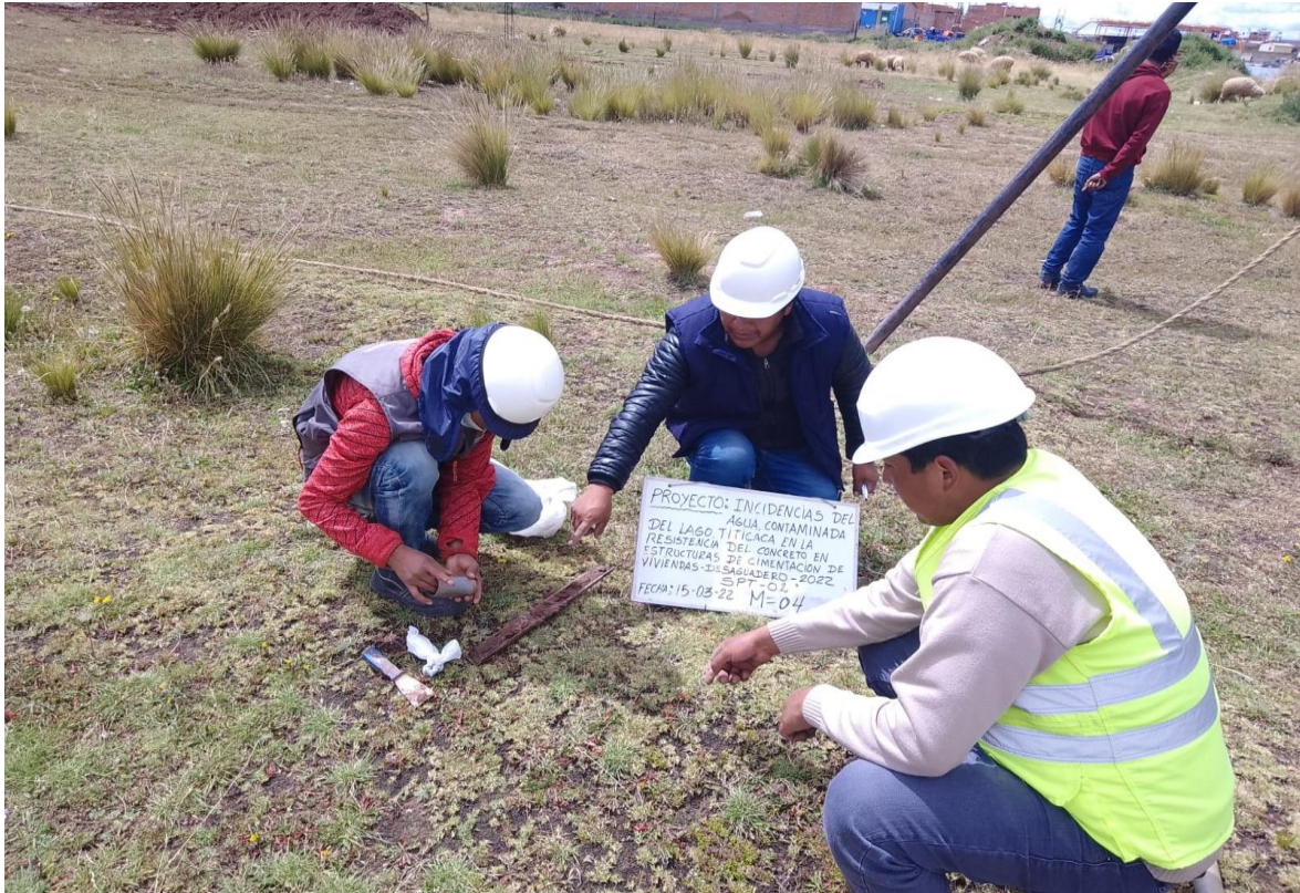
Fotografía 06 segundo punto de extracción de muestras Ensayo de Penetración Estándar (SPT).
