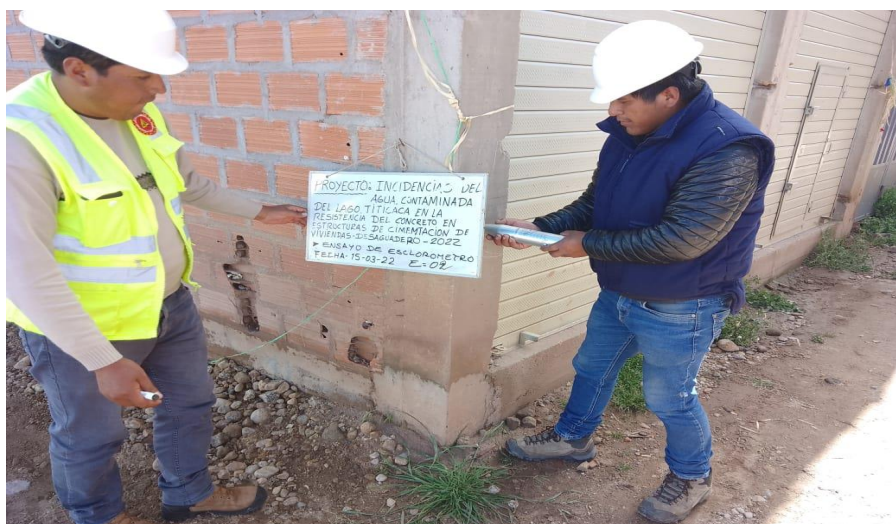
Figura 4.6. pruebas con esclerómetro instrumento utilizado para medir la resistencia del concreto en columnas de las viviendas.
