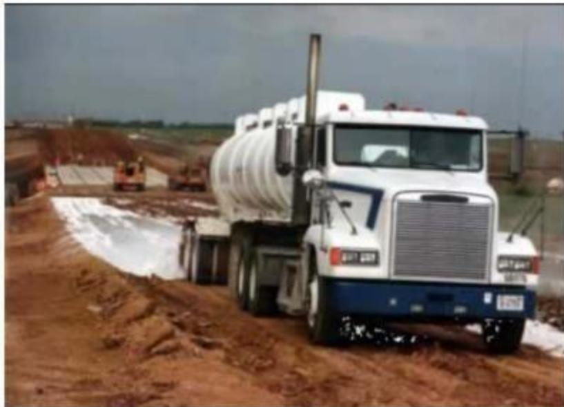
Figura N° 19: Camellones utilizados para contener la cal antes de la mezcla.
