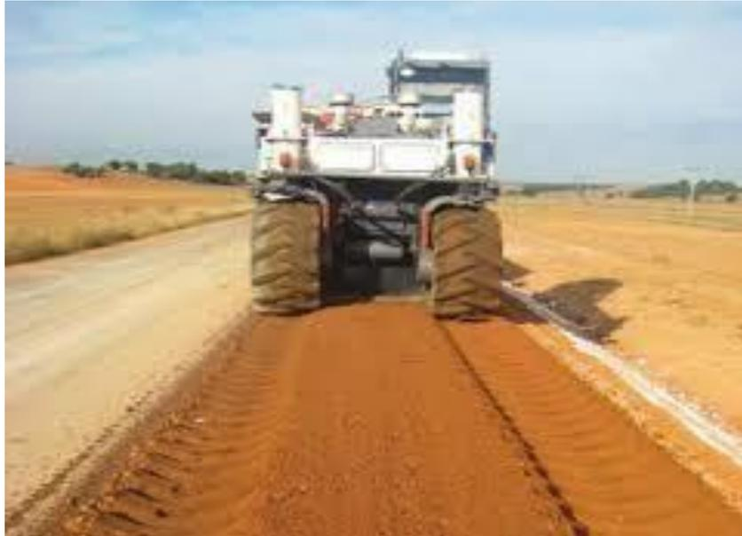
Figura N° 23: Se observa Estabilización de suelos para la homogenización inicial de los materiales.
