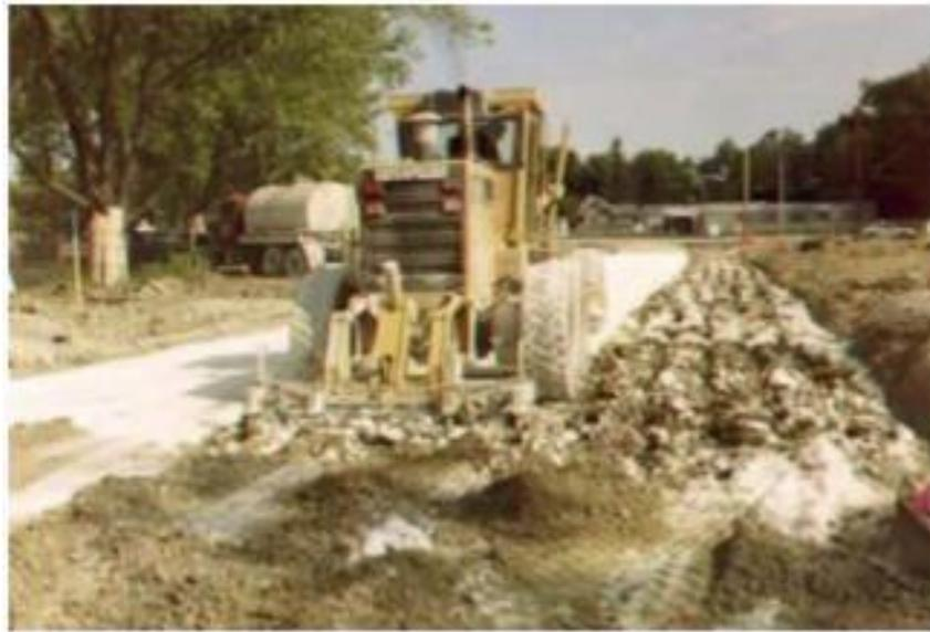
Figura N°21: Escarificación después de haberse adicionado la cal
