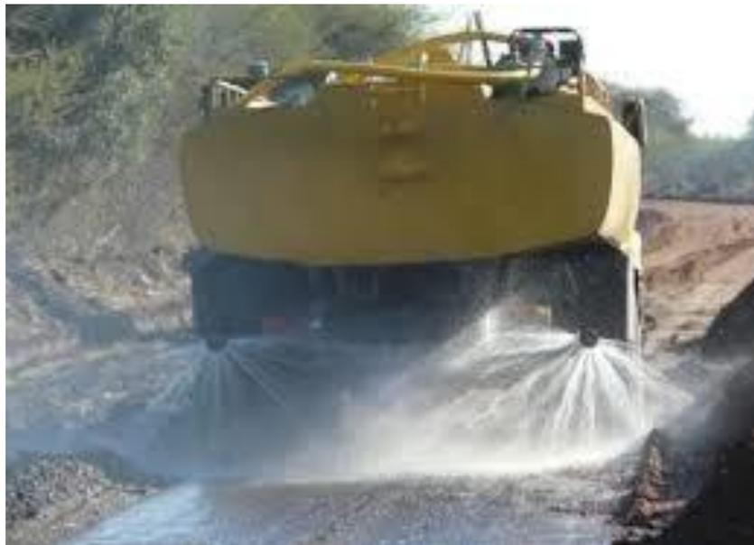
Figura N° 22: Se aprecia Adición de agua después de la escarificación
