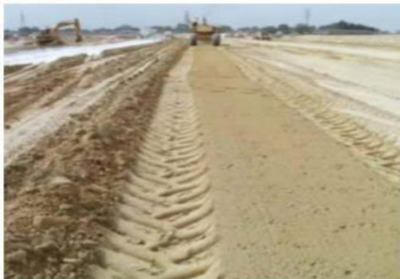
Figura N° 24: Se aprecia Pulverización de Partículas
