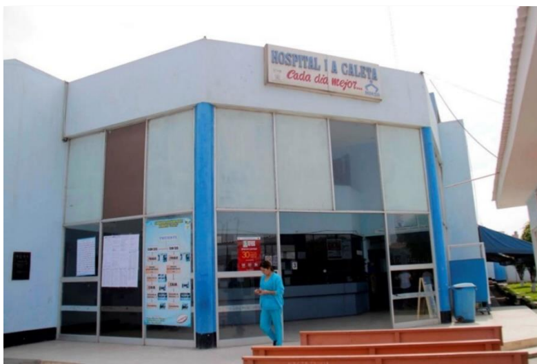
Imagen N°03: Hospital La Caleta
