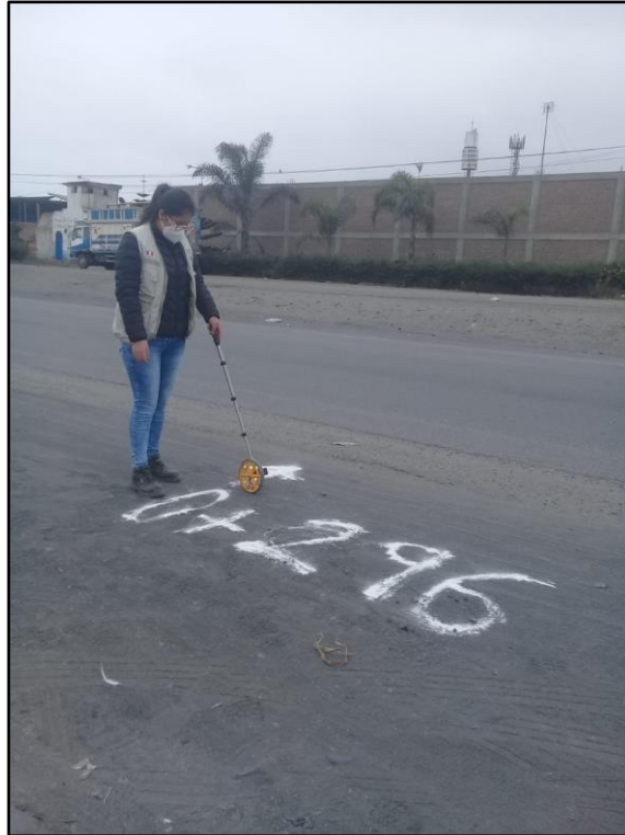
Inicio de la UM-02, comprendido entre las progresivas 0+296 – 0+333
