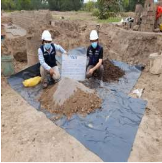
Foto 27. Material seco + ceniza.
