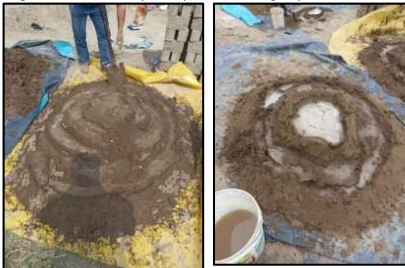
Figura 17. Mezclado y incorporación de agua para la mezcla.
