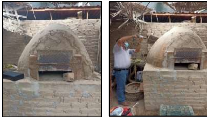
Figura 12. Acondicionamiento del horno artesanal
