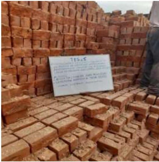
Foto 35. Ladrillos despues de coccion.
