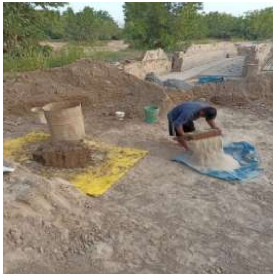
Foto 23. Mezcla con agua homogeneidad.
