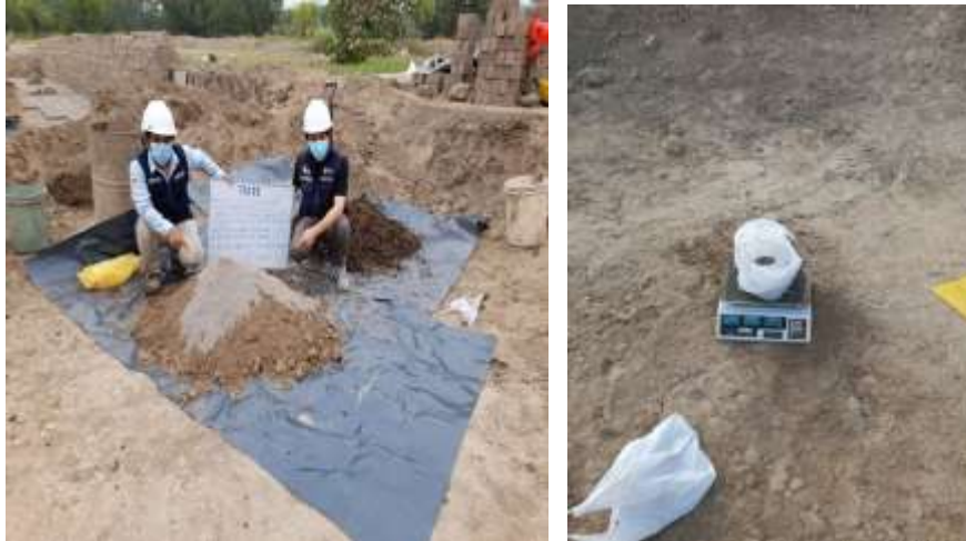
Figura 16. Dosificación de ceniza de acuerdo al peso por unidad
