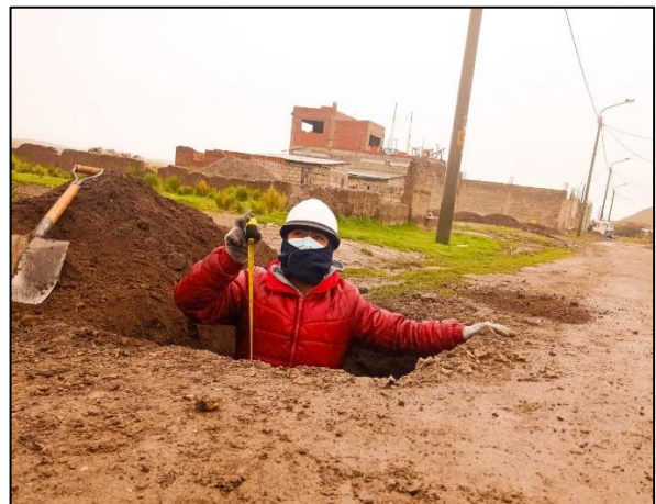
Fotografía 4: Medición de altura de excavación a cielo abierto.
