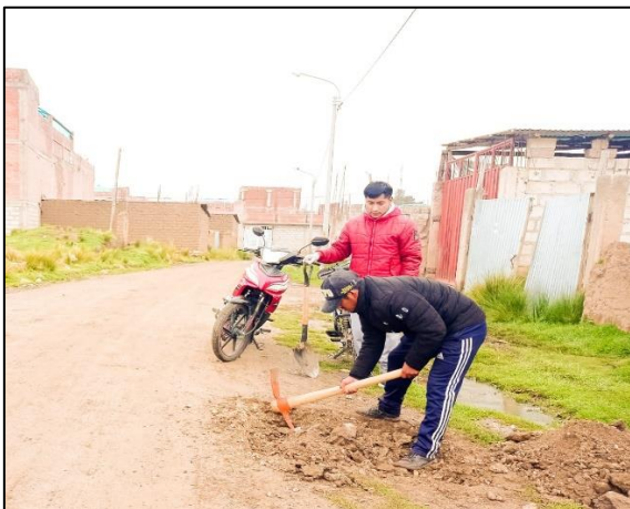
Fotografía 3: Excavación a cielo abierto.
