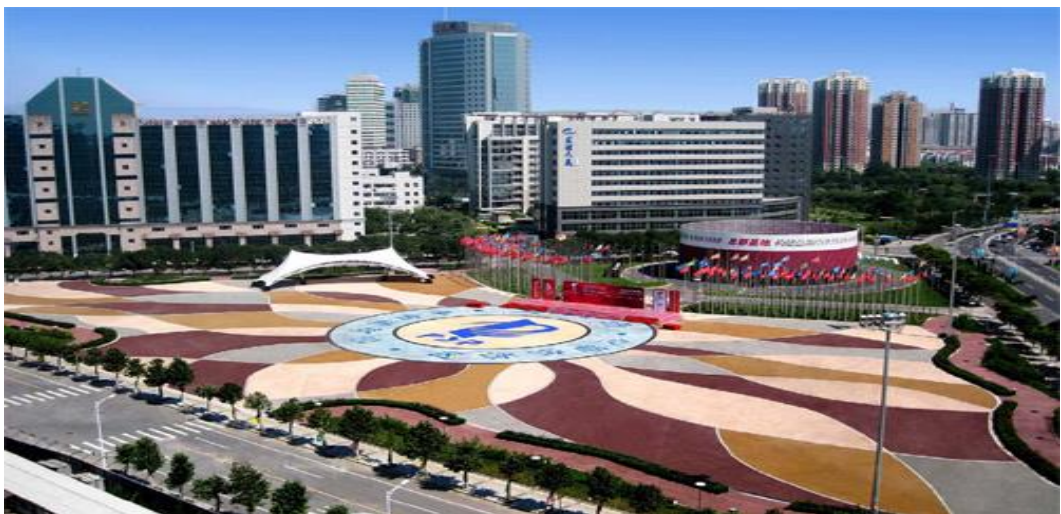
Figura 6: Uso del concreto permeable en la ciudad de Beijín, China. Fuente:
