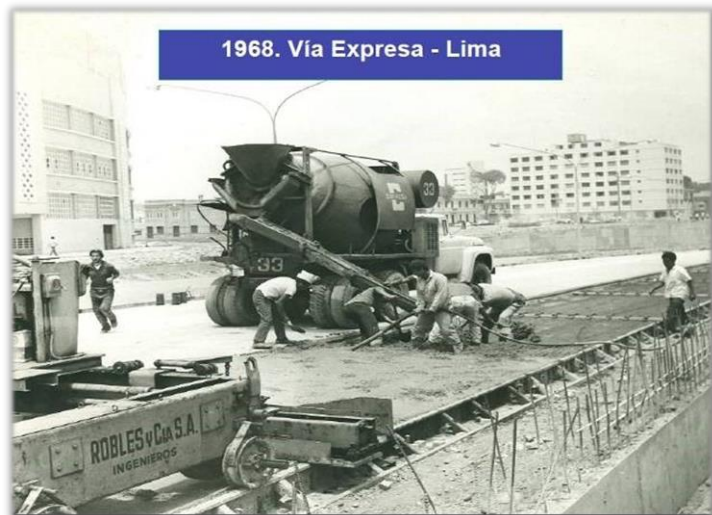
Figura 28. Edificación del pavimento rígido en la Vía Expresa.
