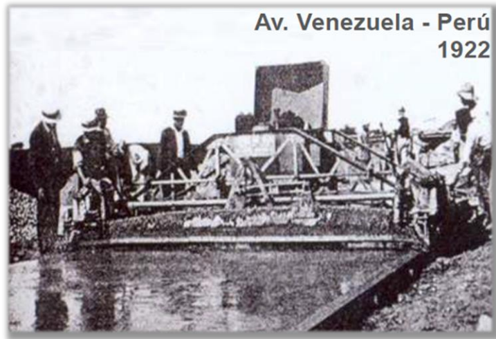
Figura 27. Edificación del pavimento rígido en la Avenida Venezuela 1922.
