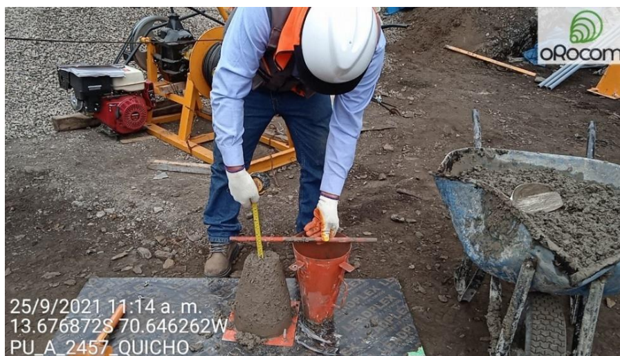
Figura 3: Medición de Slump
