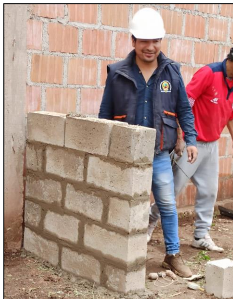
Figura 7 Murete elaborado con ladrillo de concreto modificado
