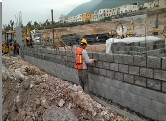
Figura 2 Muro de ladrillo de concreto
