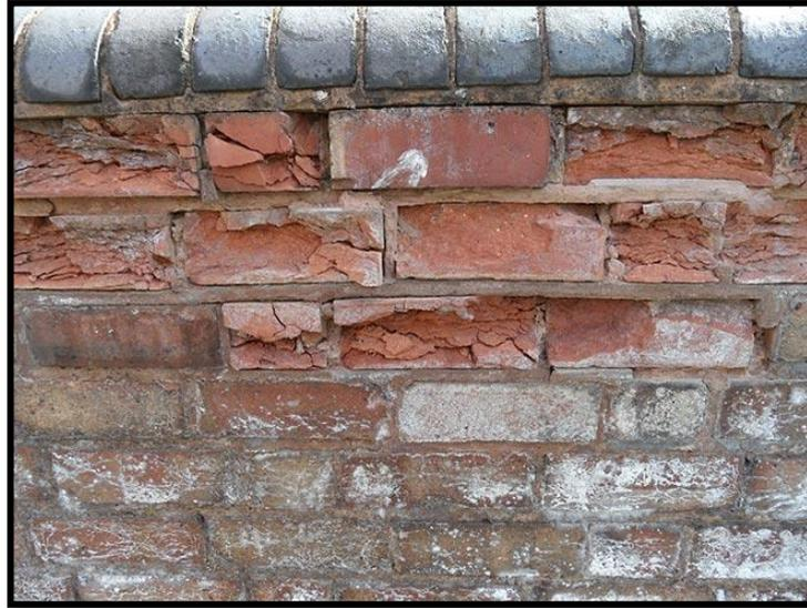
**Figura N° 20:** Defectos del ladrillo de arcilla
