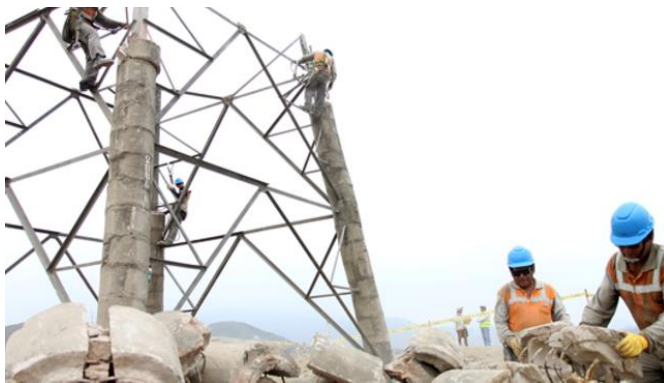
Figura 1.5 Torre de alta tensión en retirada en el año 2014
