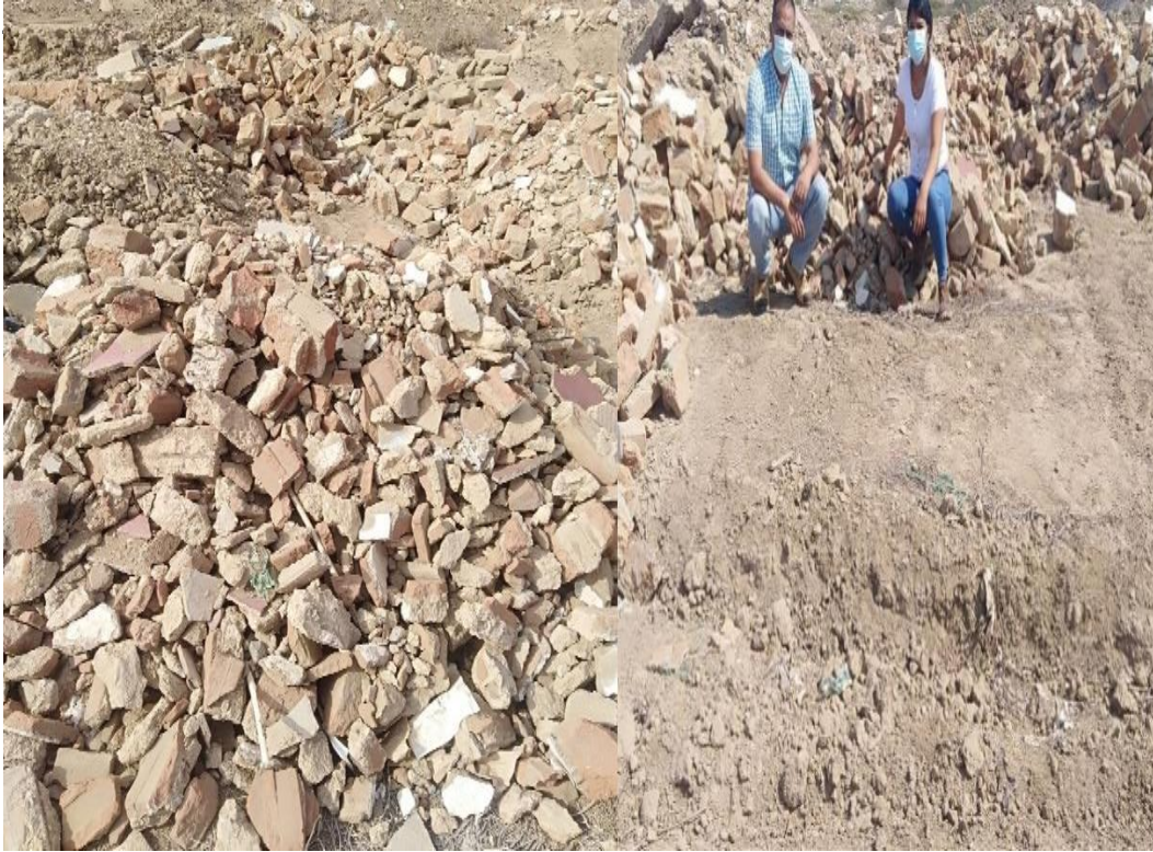
Fotografía 14: Lugar de acopio del RCD.
