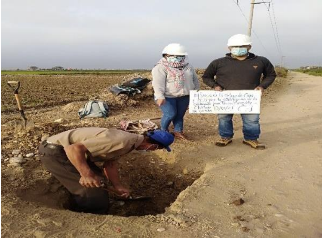
Fotografía 16: Excavación de las calicatas.
