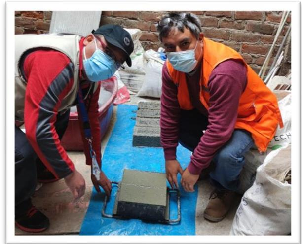
Desmoldando ladrillos de concreto
