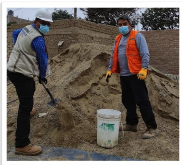
Preparando agregados para el ladrillo
