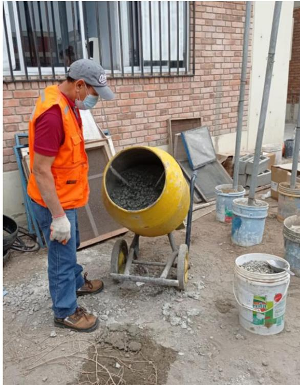
FIG 9. MEZCLANDO EN EL TROMPO
