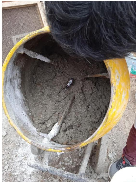
FIG 10. MIDIENDO TEMPERATURA DE LA MEZCLA
