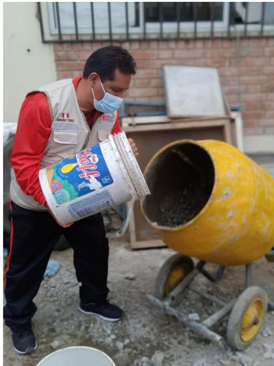
FIG 8. AGREGANDO EL AGUA A LA MEZCLA
