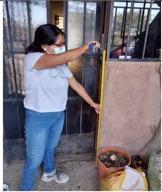
Figura 35 Toma de datos en la vivienda Se midieron los ambientes de la vivienda, se anotaron los errores en el proceso constructivo.
