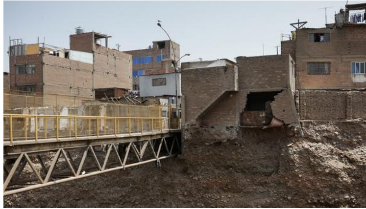
Figura 1 Viviendas construidas informalmente
