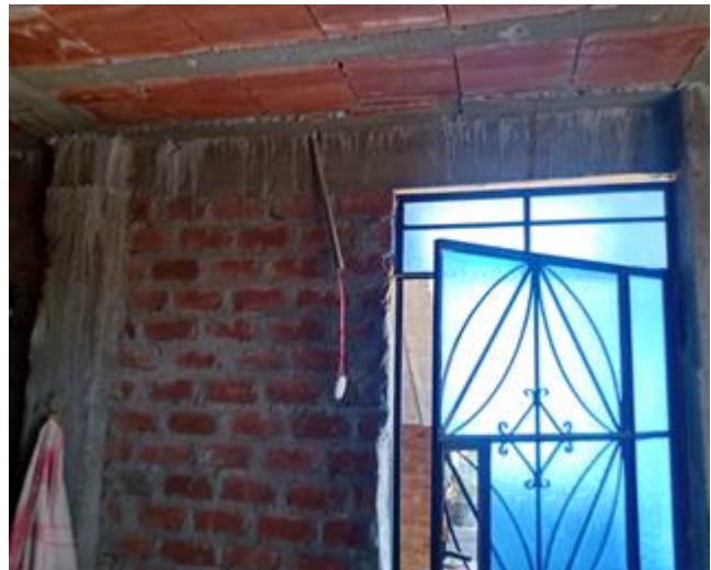
Figura 41 Dormitorio Principal – Sin acabados
