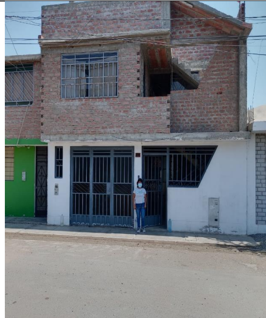
Figura 34 Fachada de la vivienda Vivienda elegida, la familia permitió el ingreso.
