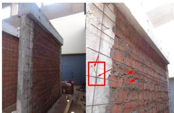
Figura 3 Reforzamiento Proceso Constructivo – Fuente: Sencico 2021
