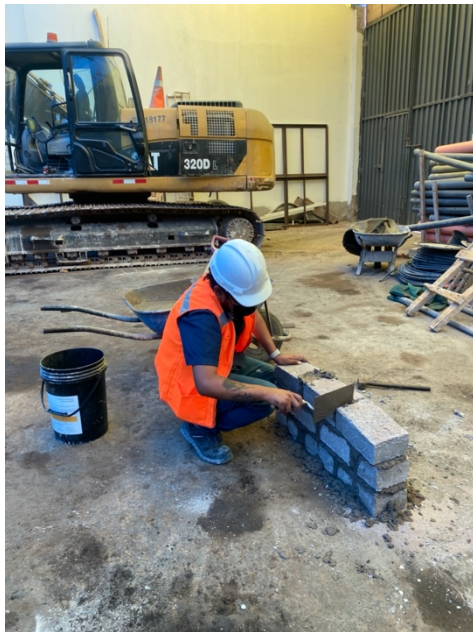
Figura 58: Elaboración de muretes
