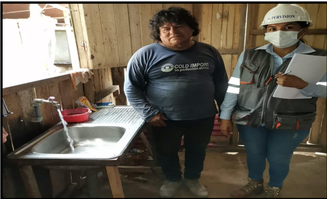
Vista fotográfica de las instalaciones de agua que abastece al área de su cocina del poblador
