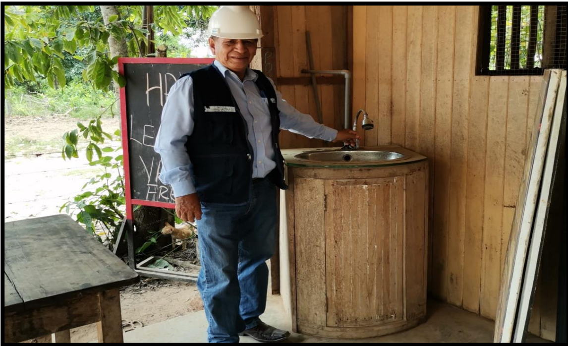
Integrante del proyecto verificando el estado en el que se encuentra las conexiones domiciliarias.
