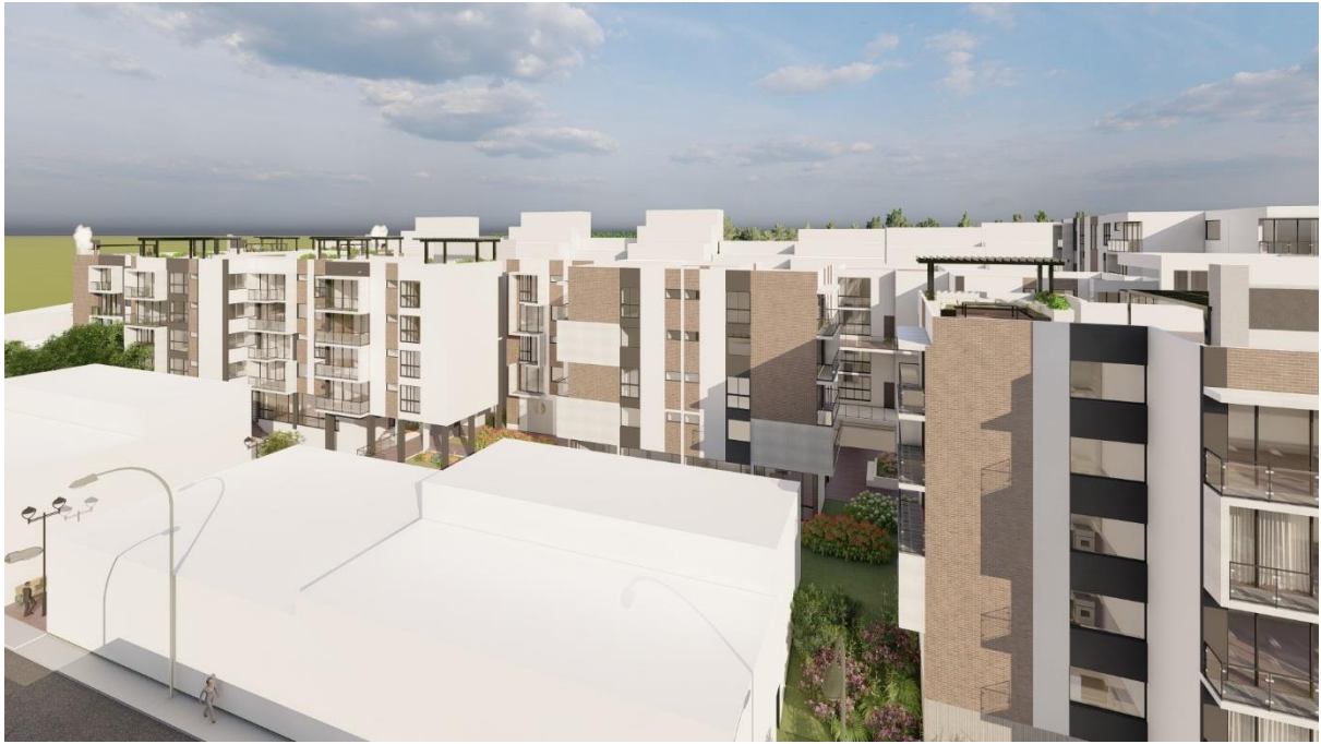
Figura 181. Vista interna del conjunto.
