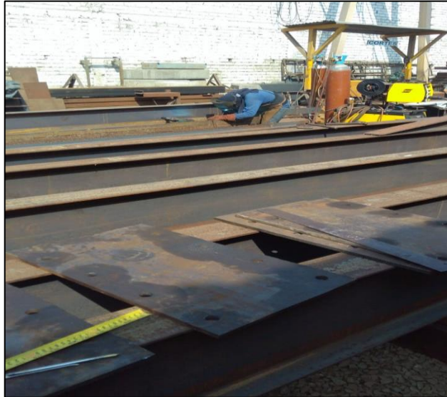
Figura 7. Manipulación y levantamiento de planchas metálicas
