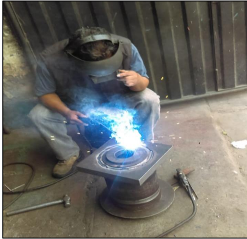
Figura 13. Soldadura con electrodo
